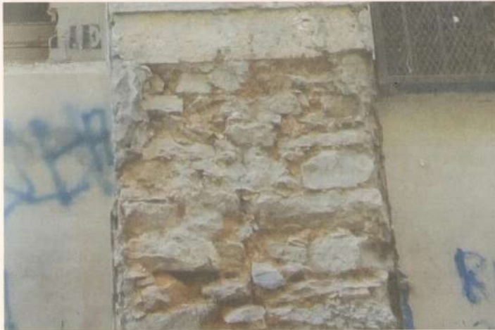
Fig. 1. Vue de la maçonnerie/ Vista de la mampostería.
