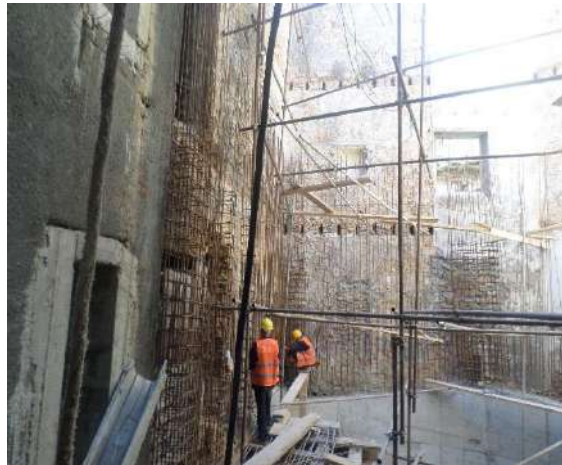
Fig.29 1: Les armatures de la cage d'escalier, source : photos prises sur chantier par l'auteur
