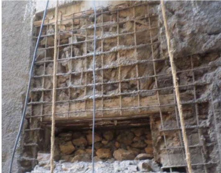
Fig.27 : Renforcement du mur porteur (partie du mur reconstruit, source : photo prise sur chantier par l'auteur
