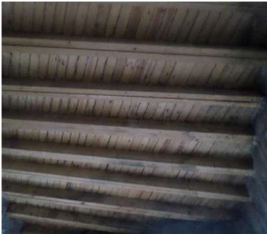
Fig.33 1: Le plancher en bois du 1 er et 2 ème étages, source : photos prises sur chantier par l'auteur
