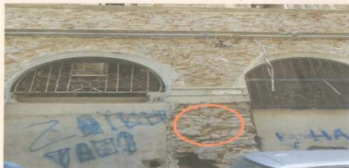
Fig. 1. Façade principale (le cercle indique l'endroit où l'échantillon a été pris) / Fachada principal (en el círculo en donde se han recogido las muestras).
