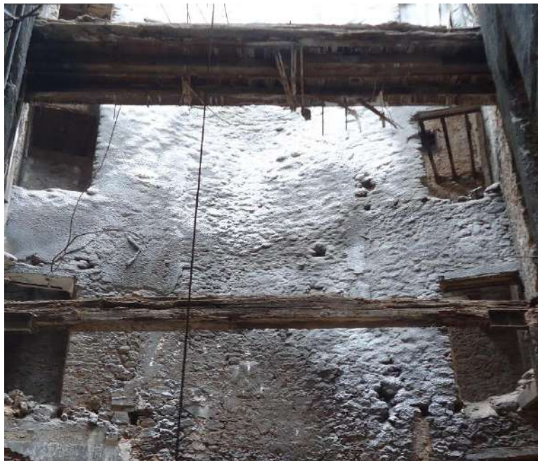
Fig.19 : L'emplacement de l'ancienne cage d'escalier, source : photographie prise par le BET
