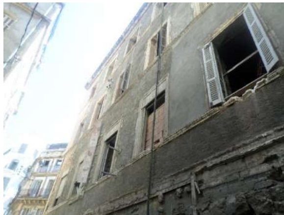
Fig.26 2 : Photographie façade actuel source : Photo prise sur chantier par l'auteur
