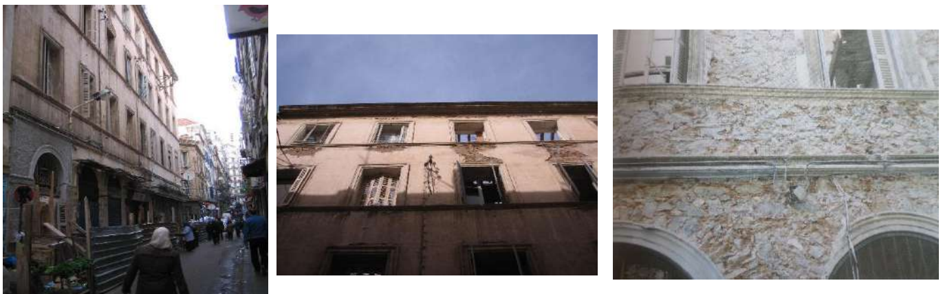
Fig.25 : état des lieux des façades (avant et après début des travaux), source : photographie prise sur chantier par le BET (dossier d'état des lieux et suivi du chantier)
