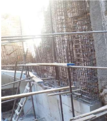
Fig.29 1: Les armatures de la cage d'escalier, source : photos prises sur chantier par l'auteur
