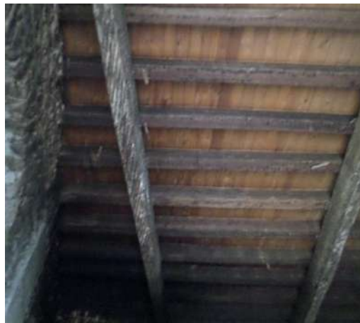
Fig.33 1: Le plancher en bois du 1 er et 2 ème étages, source : photos prises sur chantier par l'auteur
