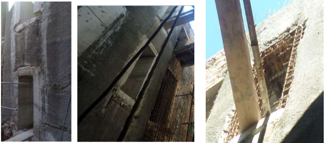
Fig.30 : Les fenêtres donnant sur le patio, source : photos prises sur chantier par l'auteur
