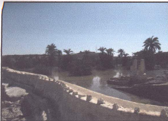
Photo. n °6 : Digue de captage des eaux de crue. (Source : Guemari, 2008)
