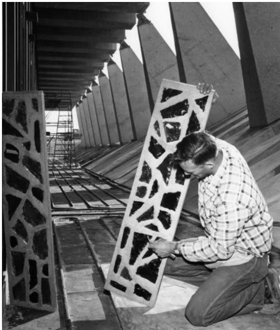
Figure 39. Préparation des bandes de vitres de la U.S.A.F.A. Cadet Chapel. Photos © SOM.
