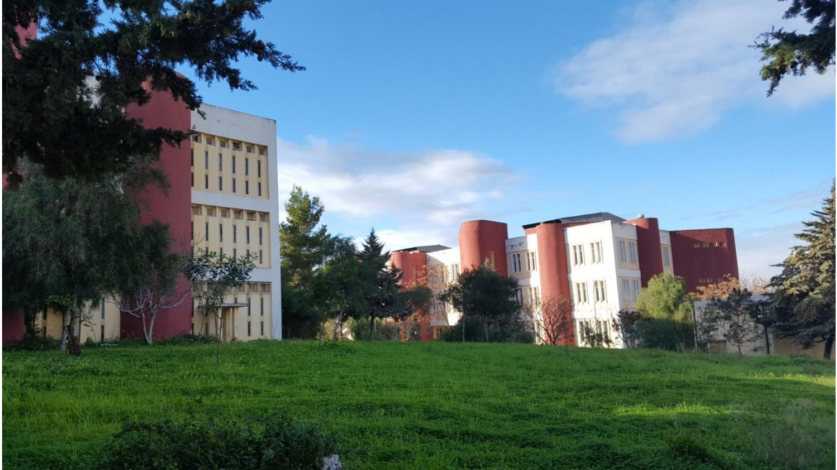
Figure A.III.1. Intégration des pavillons de l'Université de Blida 1 Saâd Dahlab au sein d'un environnement paysager.
