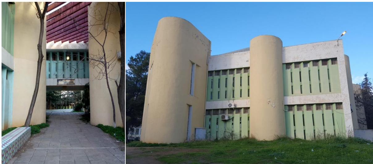
Figure 112. Le pavillon 26; un bâtiment en R+1 formé de deux blocs. Photo © Arbia Safia, Photo © Travail personnel.
