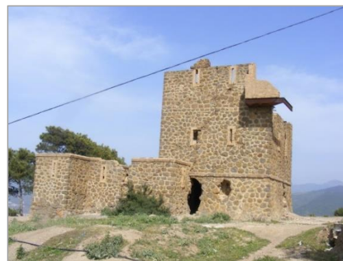
Figure 26. Poste optique de Ténès
