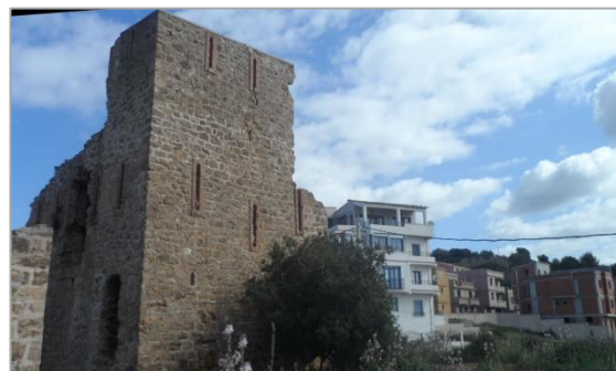
Contraste du fort avec les nouvelles constructions
