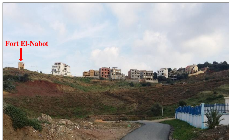
Figure 49. Etude du bâti au niveau de la trame secondaire
