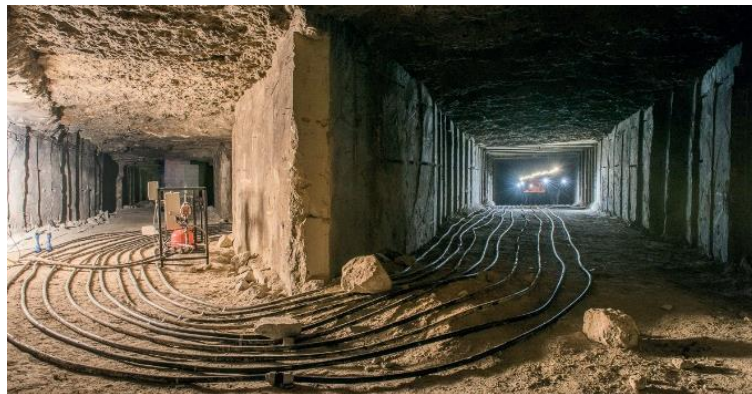
Figure 48 : Galeries souterraines Saumuroises (Source : la Région des Pays de la Loire, 2016)
