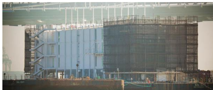
Figure 52 : Datacenter flottant de Google (Source : journaldugeek, 2013)
