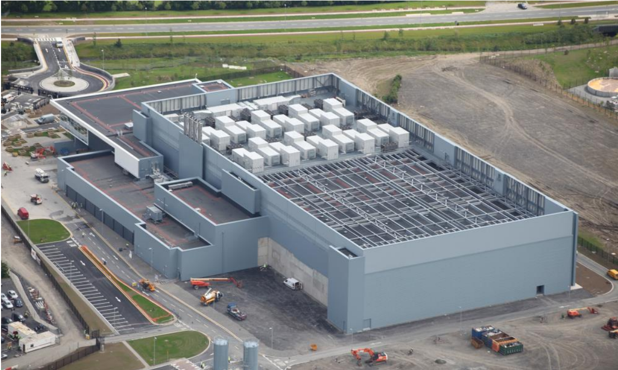
Figure 11 : Vue d'ensemble sur le datacenter Microsoft en France (Source : Bergé, 2016)
