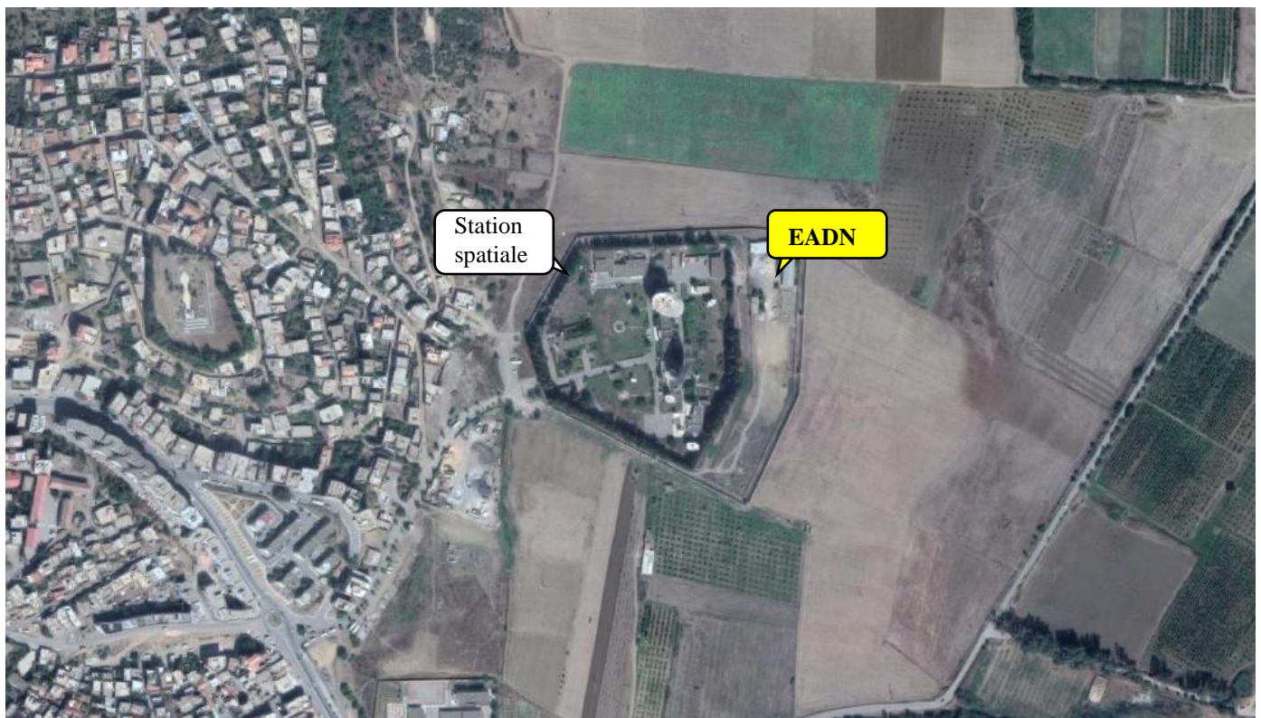
Figure 55 : Situation géographique du datacenter d'EADN dans la station spatiale de Lakhdaria
