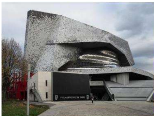
Fig. n°21 :Vue extérieure de la Philharmonie de Paris
