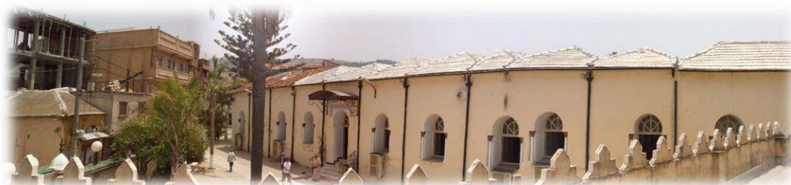
Figure 96: photo montre la toiture de la mosquée
