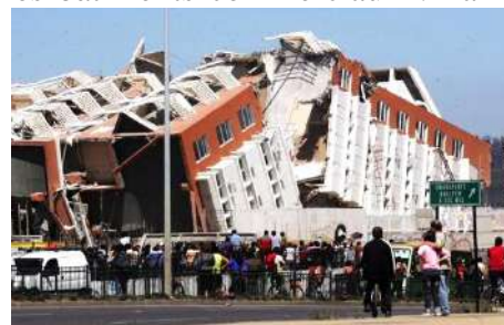
Figure 38:dégâts Séisme de 2010 au Chili
