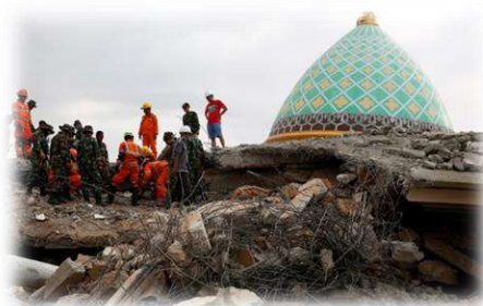
Figure 22: ruine de la mosquée après le séisme
