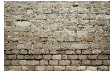
Figure 57: mur en moellon
