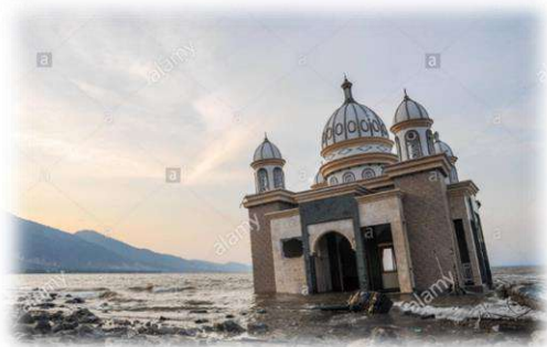
Figure 23:le tsunami a emporté la moquée dans la mer
