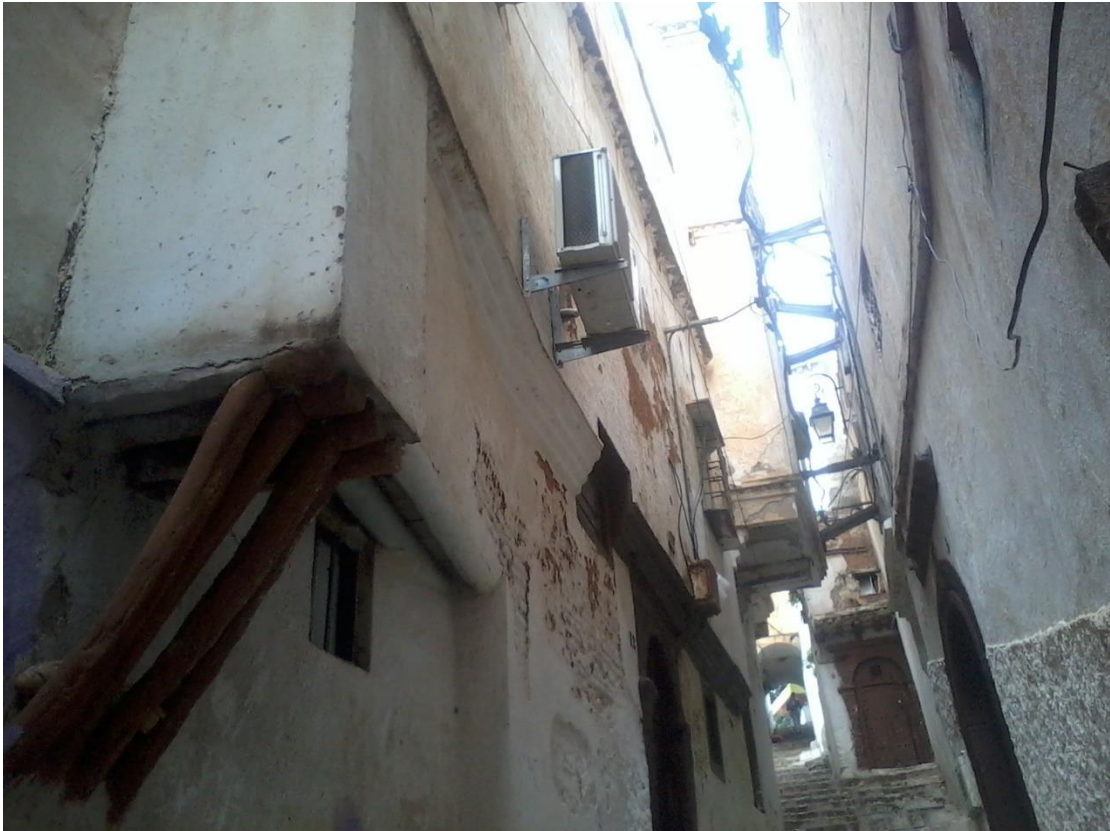
Figure 57 : La prise de photo de la façade
