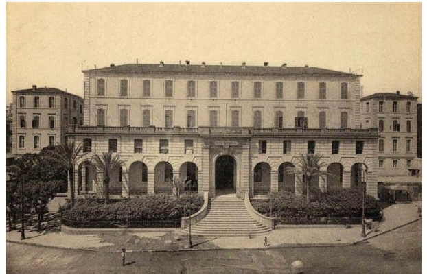
Figure 16 : Photo sur la Façade principale du Lycée Emir
