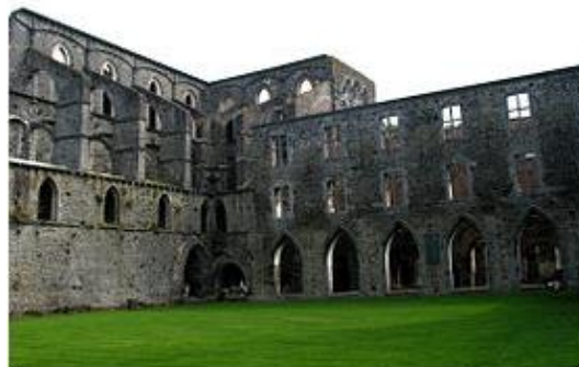
Figure 6 : Ruines du transept sud de l'abbatiale de Villers
