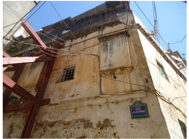
Figure 37 : Etalement de la façade
