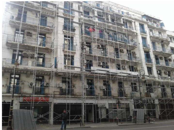
Figure 4: Préparation de chantier de travaux boulevard colonel amirouche (auteur 2017)
