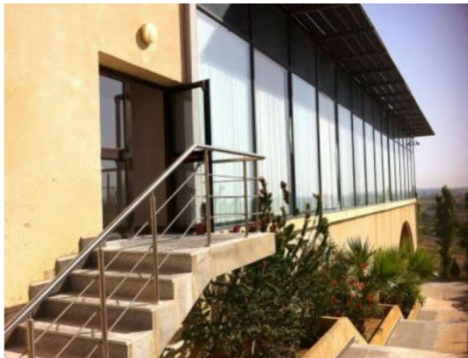
Figure 29 : vue sur l'entrée du bâtiment Source : auteur, 2016
