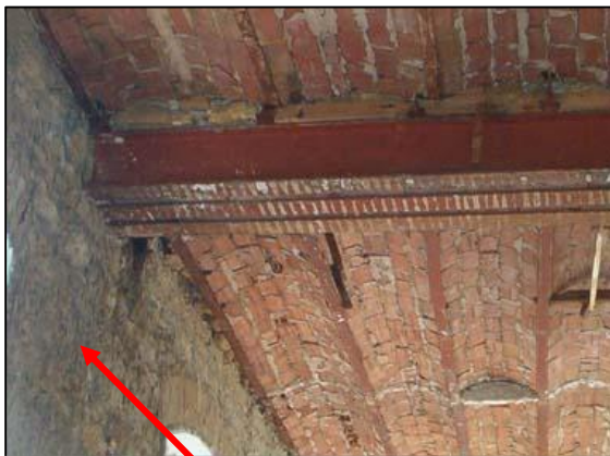
Figure 4.8 : murs en maçonnerie de pierre au niveau de l'étage
