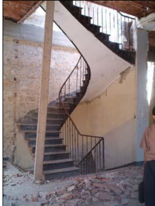
Figure 4.17 : vue sur l'escalier balancé en bois
