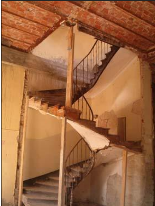
Figure 4.16 : vue sur l'escalier hélicoïdale en bois avec l'importance de la hauteur sous plafond
