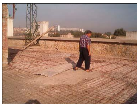
Figure 4.40 : Consolidation de la toiture terrasse
