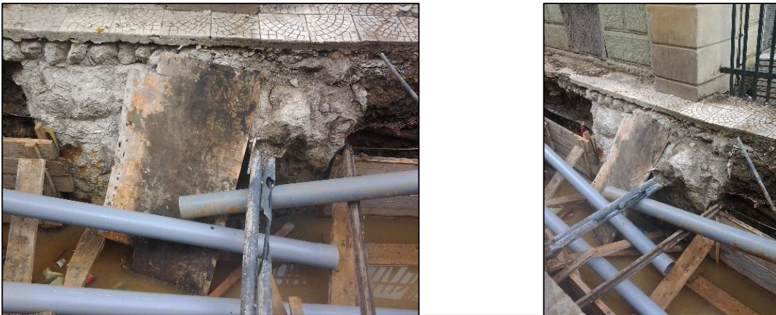
Figure 4.63 : renforcement des fondations par le béton armé
