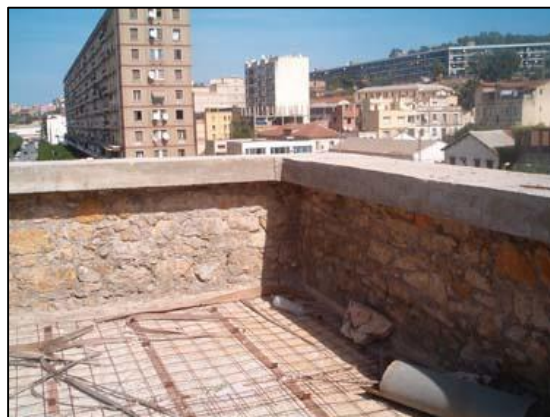
Figure 4.9 : murs en maçonnerie de pierre au niveau de l'acrotère de la terrasse
