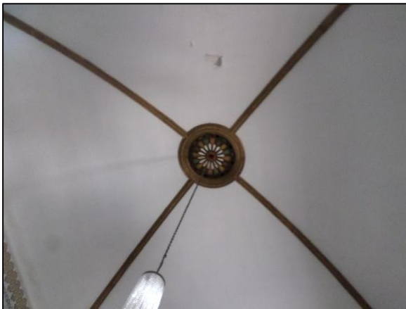
Figure 4.18 : Vue sur le sommet de la coupole
