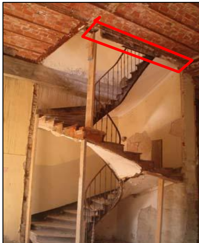
Figure 4.79 : La connexion de l'escalier au plancher
