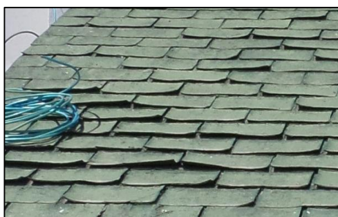
Figure 4.61 : état dégradé de feutre en bitume
