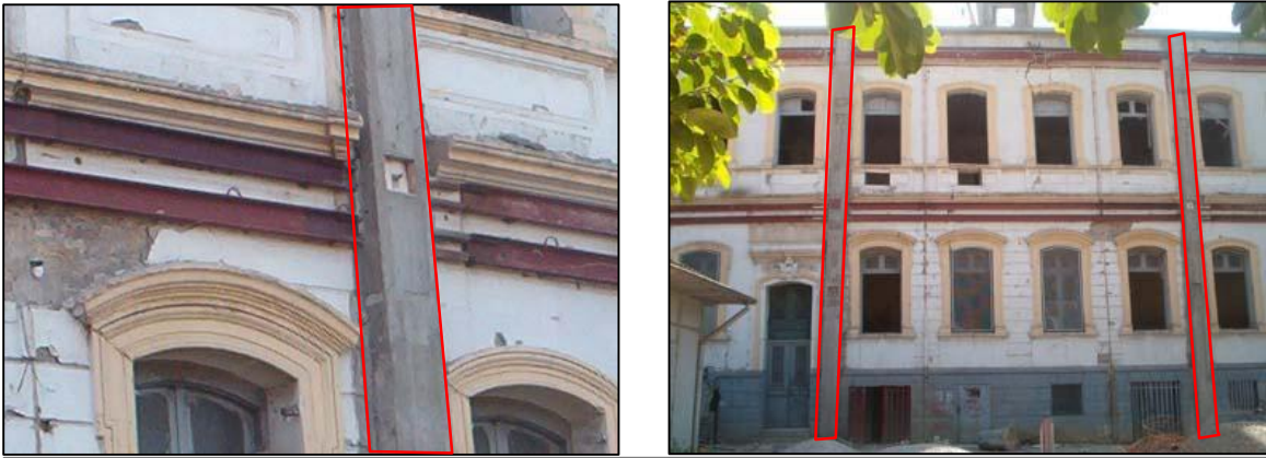
Figure 4.66 : technique de chemisage vertical en béton armé
