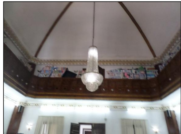
Figure 4.19 : La coupole en plâtre comme couverture pour la salle des réunions
