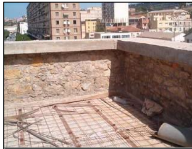
Figure 4.76 : Ferrailage en treillis soudés
