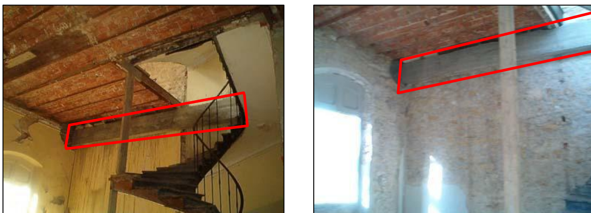
Figure 4.74 : poutres de renforcement en béton armé
