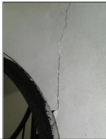
Figure 4.55 : décollements, fissures graves au-dessous des marches de l'escalier
