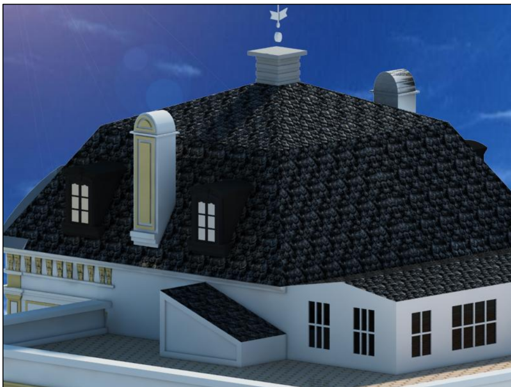
Figure 5.19 : charpente en ardoise artificielle et fenêtres en bois
