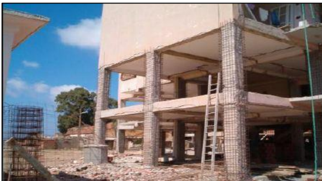
Figures 3.22 : renforcement des poteaux par chemisage en BA
