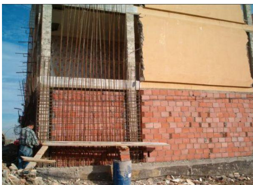
Figures 3.30 : Consolidation par murs de contreventement
