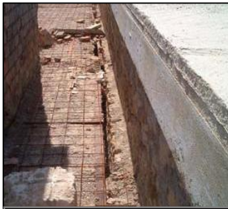
Figure 4.75 : Fissure filante
