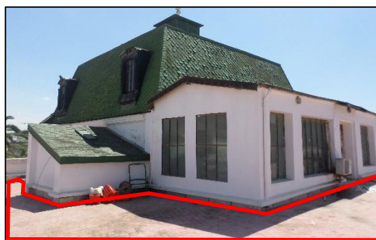
Figure 4.41 : Nouveau socle après consolidation
