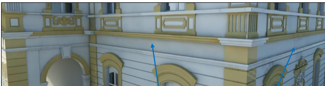
Figure 4.39 : photo en 3D pour illustrer l'existence de bandes horizontales rentrantes (avant l'intervention)
