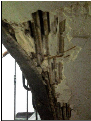
Figure 4.55 : décollements, fissures graves au-dessous des marches de l'escalier
