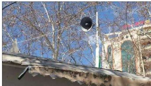
Figure 52 installation des hauts parleurs de la mosquée El Atik à la place Ain Elfouara. Source : établie par l'auteur, cliché 2016.
