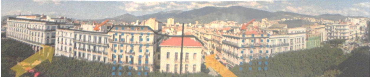
Fig. 26, photo panoramique des façades du Cours de la Révolution Source : auteure
