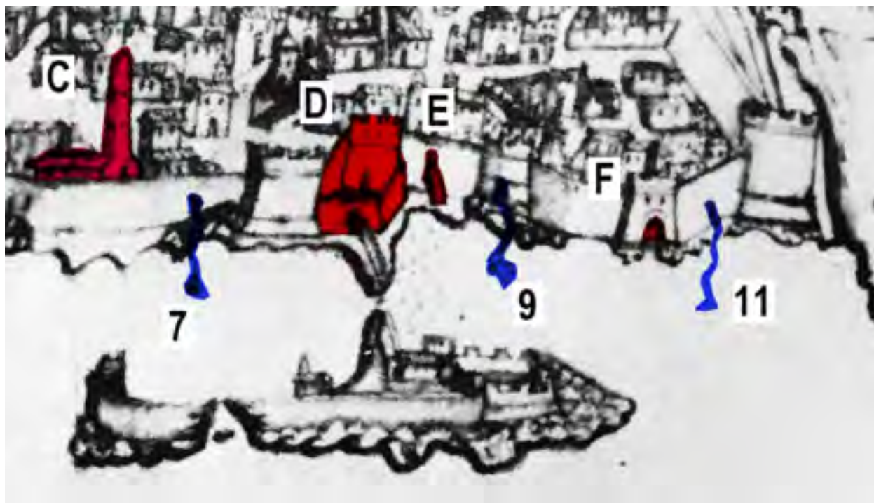
Fig.80 - Alger en 1604 , les exutoires des eaux de la partie Nord du mur de rempart du front de mer.
