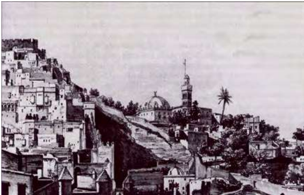
Fig.24 - L'escarpement vu depuis la porte de Bab el-Oued en 1830. (Vue en 1830 depuis Bab al-Oued sur le sanctuaire de 'Abd al-Rahman al-Tha'alibi avec la tour qui aurait protégé Bab al-Djnan, extrait de MISSOUM, Sakina. Alger à l'époque ottomane, la médina et la maison traditionnelle , INAS, Alger, 2003, p.27.)
