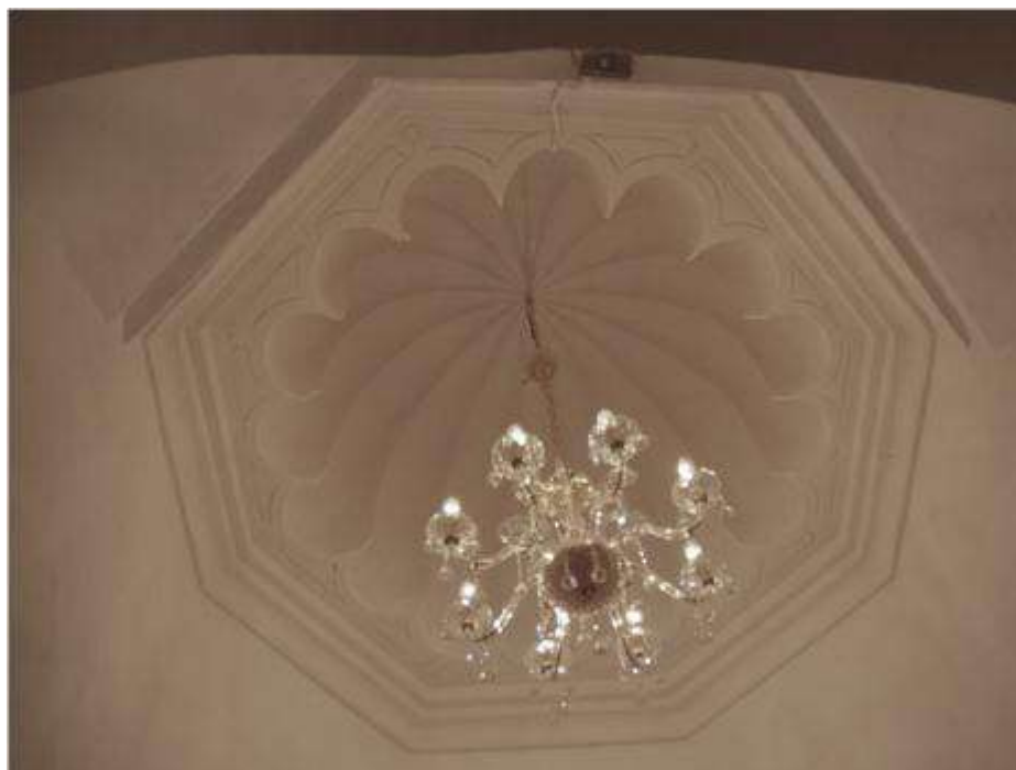
Photo 18 : Coupole du Mihrab
