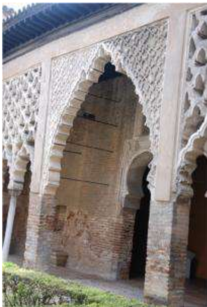
Photo 28 : Arc du Palacio el Yeso, Alcazar, Séville
