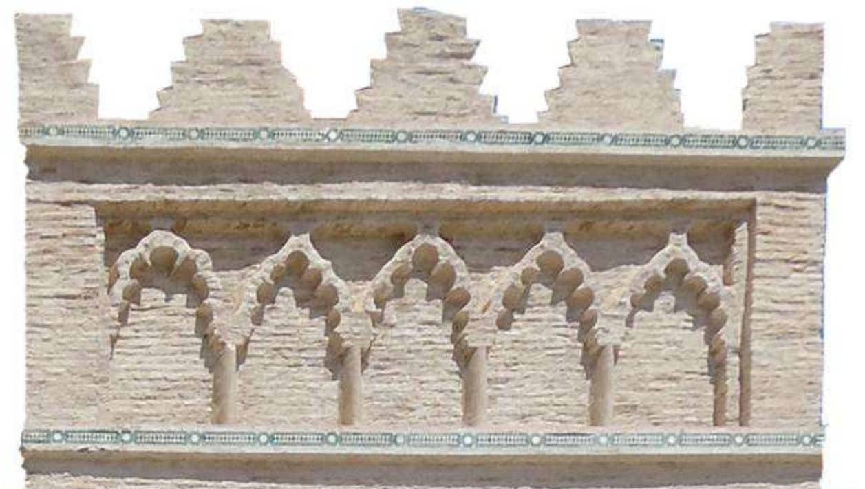
Photo 42 : Panneau supérieur, frise et merlons
