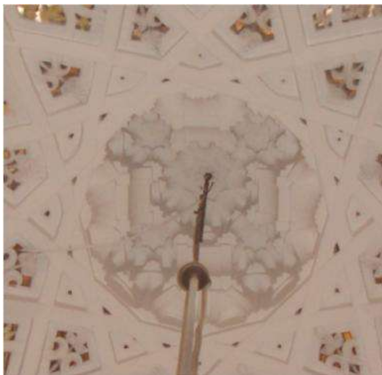
Photo 36 : Détail la lanterne de la coupole de la Grande Mosquée de Tlemcen
