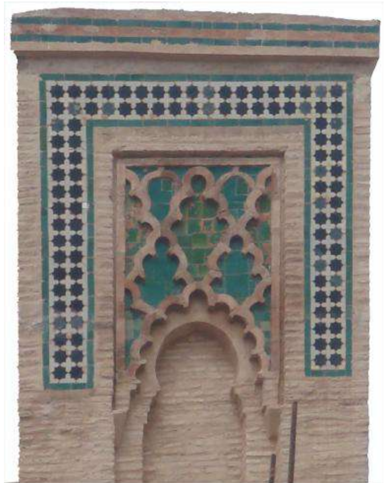
Photo 41 : Face ouest (photographie redressé)
