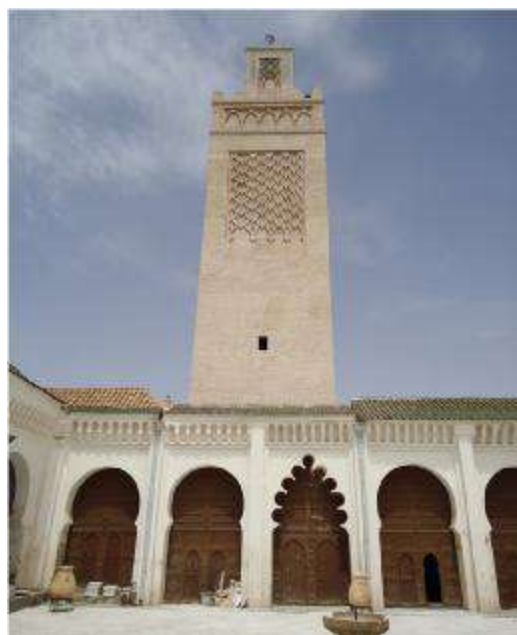
Photo 26 : Face sud du minaret
