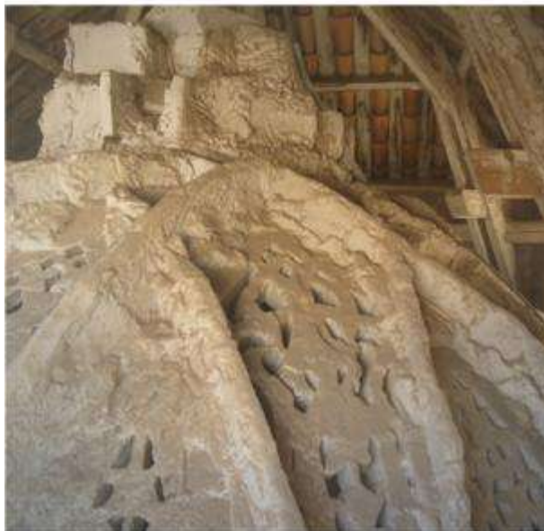
Photo 35 : Détail constructif de la coupole en avant du Mihrab, Grande Mosquée de Tlemcen
