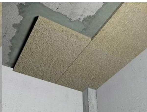
Figure 30 : Illustration représentant la pose d'une isolation thermique sous plancher par collage avec un mortier colle. (source : CYPE Ingenieros. FIF Planchers. [en ligne]. http://www.algerie.prix-construction.info/renovation/Amenagements_et_finitions/Isolations_interieures/Planchers/FIF010_Isolation_thermique_sous_plancher__0_0_0_0_0_1.html [Consulté le: 10 septembre 2017].)
