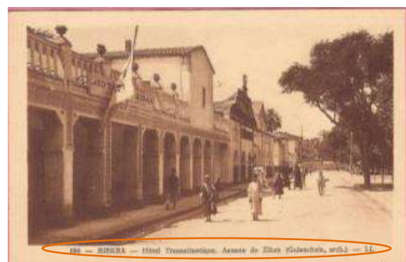
Fig. 206. Hôtel les Ziban- Biskra - Façade principale- Guiauchain architecte Source : http://www.delcampe.net
