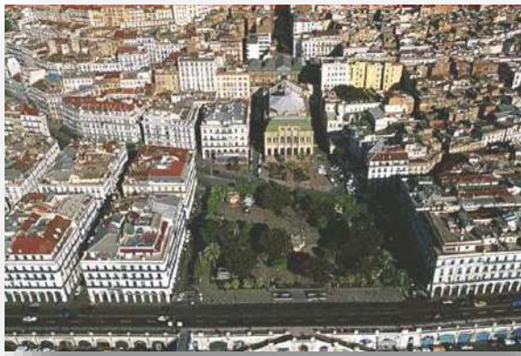
Figure 56: Square Port Saïd. Source : Site Internet. Photos d'Alger
