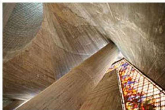
Fig 67 : Vue sur un détail montrant les traces de coffrages
