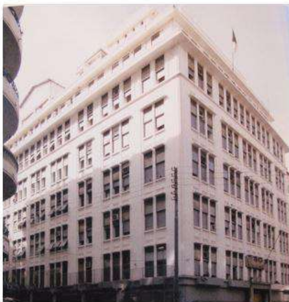
Fig 31 : Immeuble de la Sonatrach, Paul Guion, Alger, 1933
