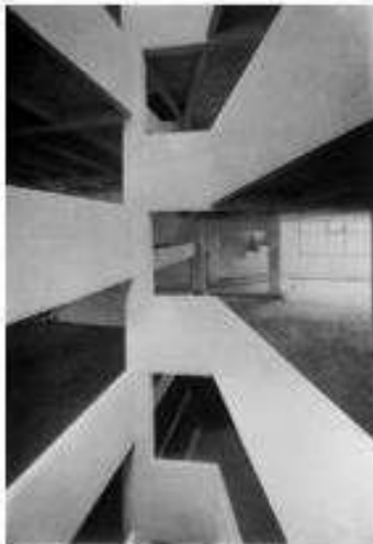
Fig 10 : Garage Vinson, Alger (Source : www.archizoom.epfl.ch )
