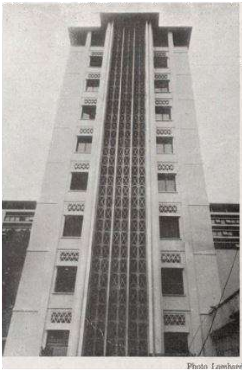
Fig 47 : Cage d'escalier du Palais du Gouvernement Général d'Algérie
