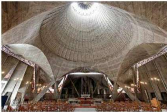
Fig 64 : Vue intérieure de l'église du Sacré-Cœur d'Alger
