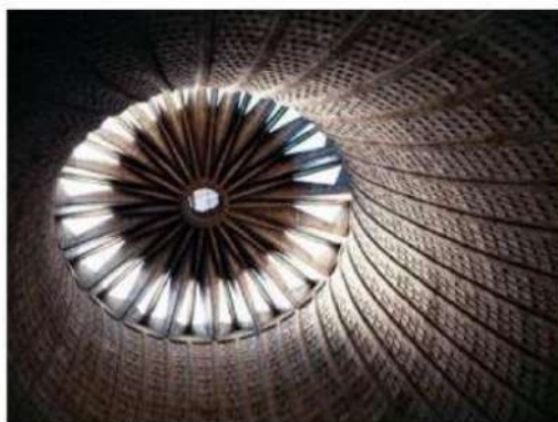
Fig 66 : Vue sur la face intérieure nervurée de la tour
