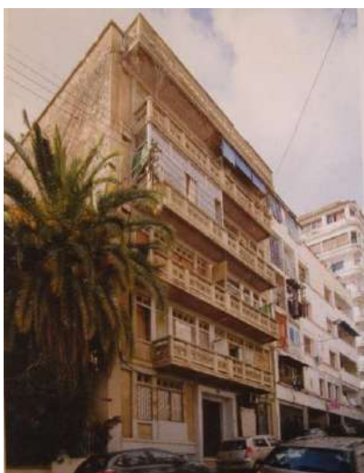
Fig 56 : Vue extérieure actuelle de l'immeuble Desfontaines (Source : PIATON Caudine, HUEBER Juliette, AICHE Boussad, LOCHARD Thierry « Alger, ville et architecture 1830-1940 », Ed. Barzakh, 2016, Pp. 289)
