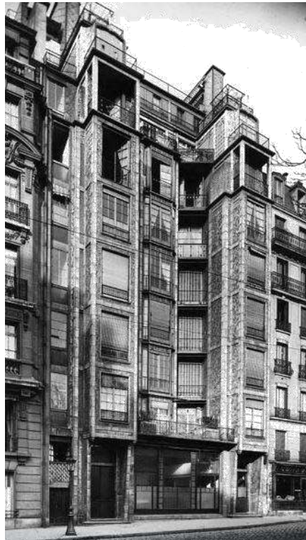
Fig 22 : Photographie de l'immeuble de la rue Franklin, A. Perret, Paris 1903/1904
