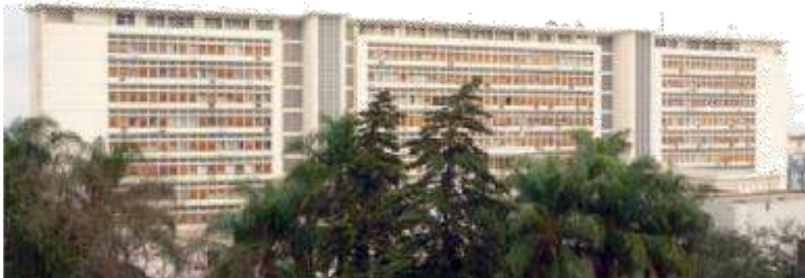
Fig 43 : Façade sur Boulevard Khemisti du Palais du Gouvernement Général (Source : www. http://mutualheritage-alger.univ-tours.fr )
