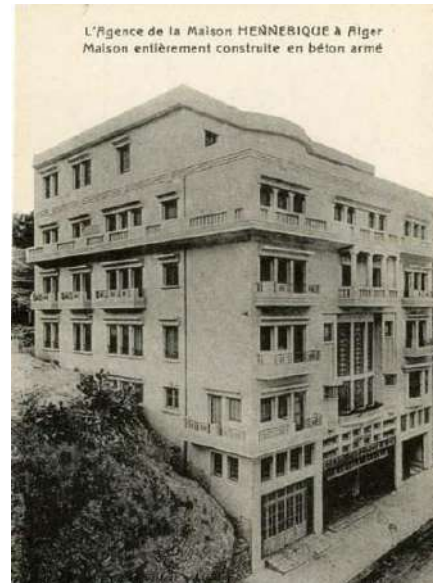
Fig 7 : siège de la firme Hennebique à Alger (Source : Centre d'archives d'architecture du XXe siècle, Fond Hennebique)
