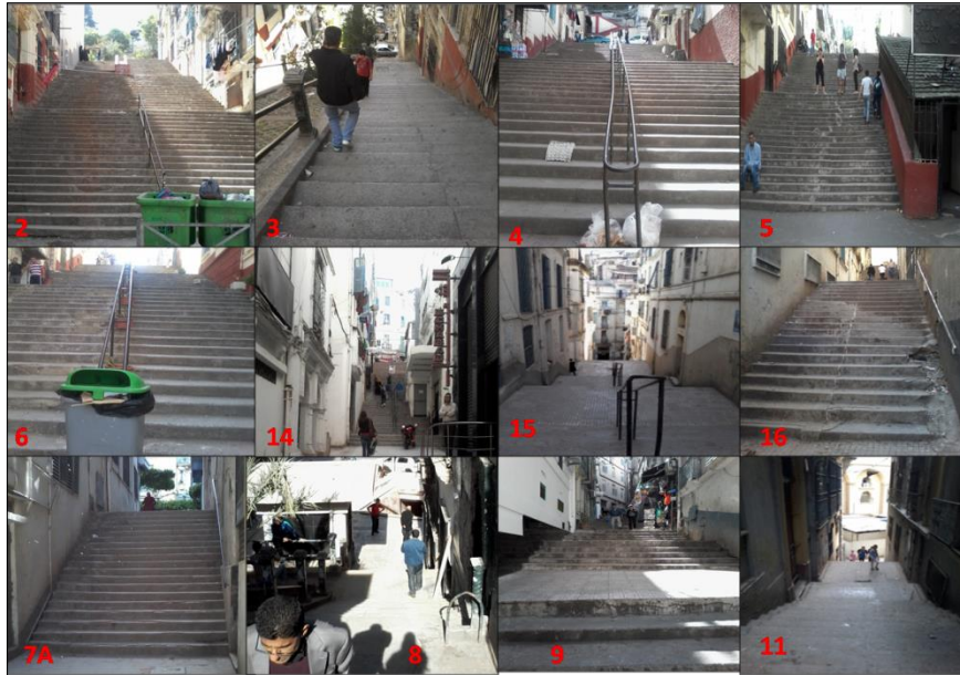
Fig. 53 : Des escaliers urbains (volées en plein largeur).
