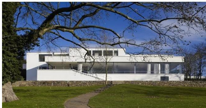
Fig.09 : La villa Tugendhat, Architecte: Mies Van Der Rohe, 1928-1930.
