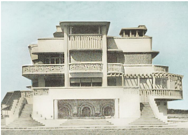
Fig.28 : Façade Vers la route de Sidi-Moussa. Source : Chantiers Nord Africains., Op.cit., p.554.
