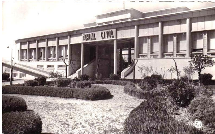
Fig.48 : l'accès principal à l'hôpital de Sétif.
