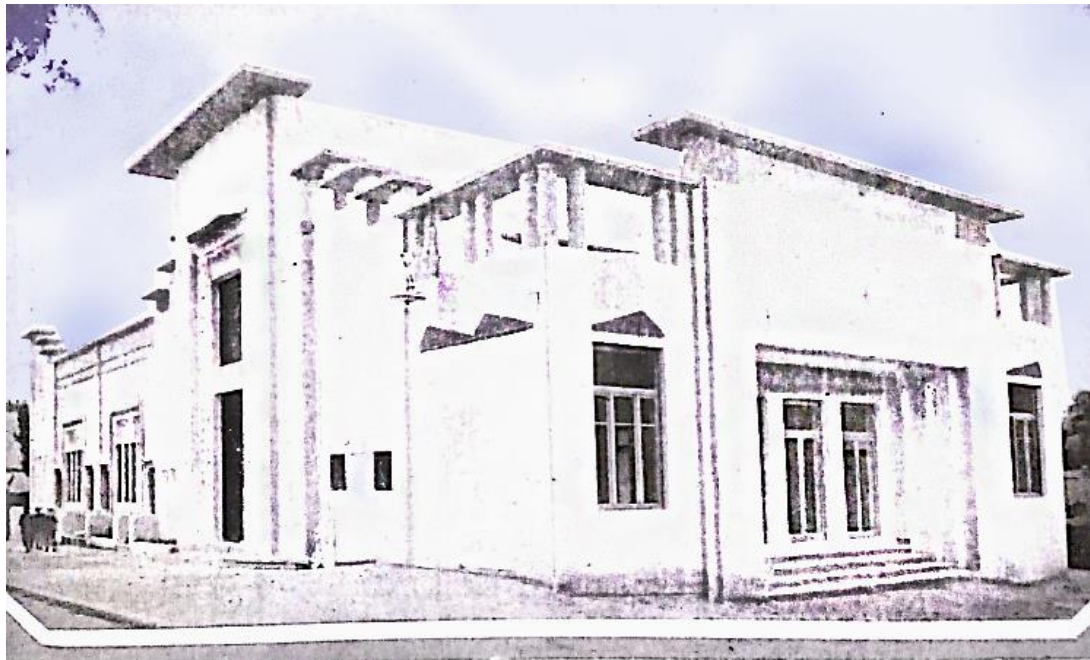
Fig.36 : vue, sur l'entrée principale de la salle des fêtes.
