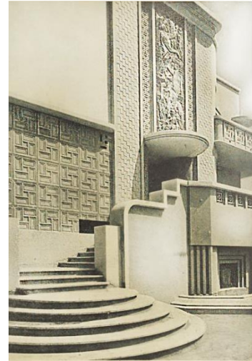
Fig.26 : Détail sur la porte d'entrée.
