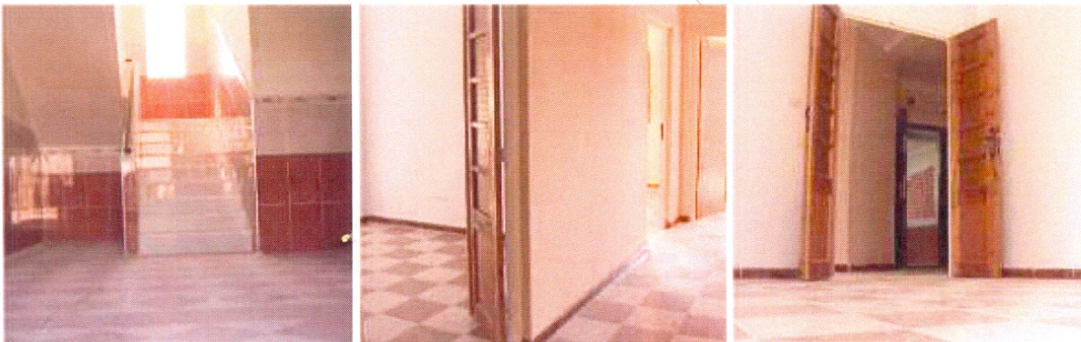
➤ Figure 19, 20, 21 : finition intérieur d'immeuble et logement
