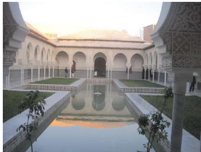
Illustration 15-2 : Le Palais d'El Mechouar après les travaux de restitution
