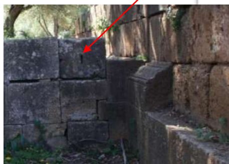
Levage des blocs de pierres
