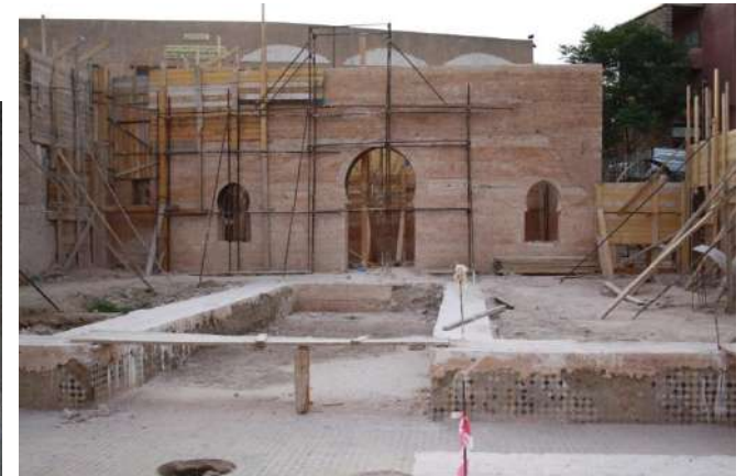
Illustration 15-3 : Le chantier pendant les travaux de restitution
