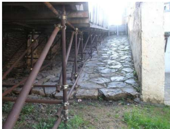
Illustration 16-1 : Vue sur la rampe restituée près des casemates menant à la Batterie-2 (sur la photo apparaît le support de la nouvelle passerelle en bois)
