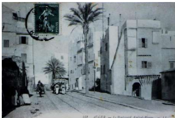
Illustration 13-1 : vue d'ensemble avant les travaux de restauration
