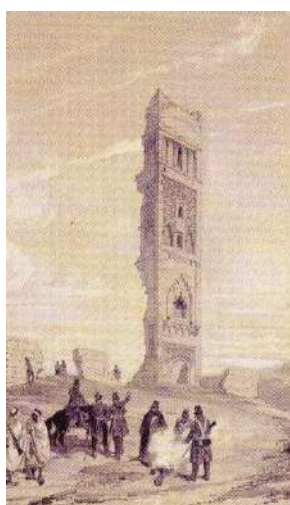
Illustration 8-3 Le minaret de la mosquée avant les travaux
