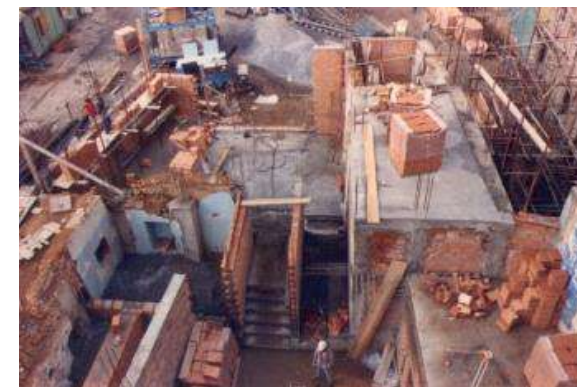
Illustration 13-3 : Le chantier pendant les travaux de restauration
