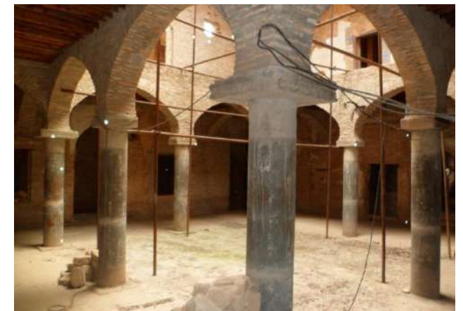
Illustration 16-4 : cour du Palais des Beys (Etat après démolition des piliers et mise en place des buses en ciment provisoires en remplacement des
