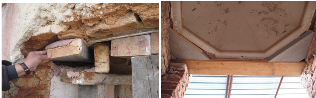
Photo 23 : Les différentes étapes de la restauration du volume de la sortie vers le Stah 290 .
