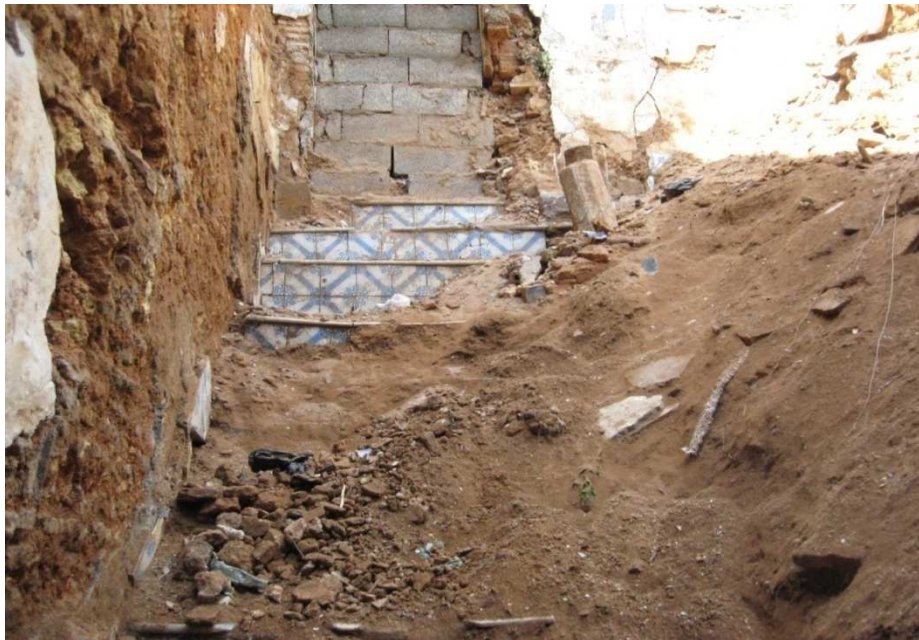
Photo 9 : L'escalier de la Dar N°57 rue Rabah Riyah 227 .
