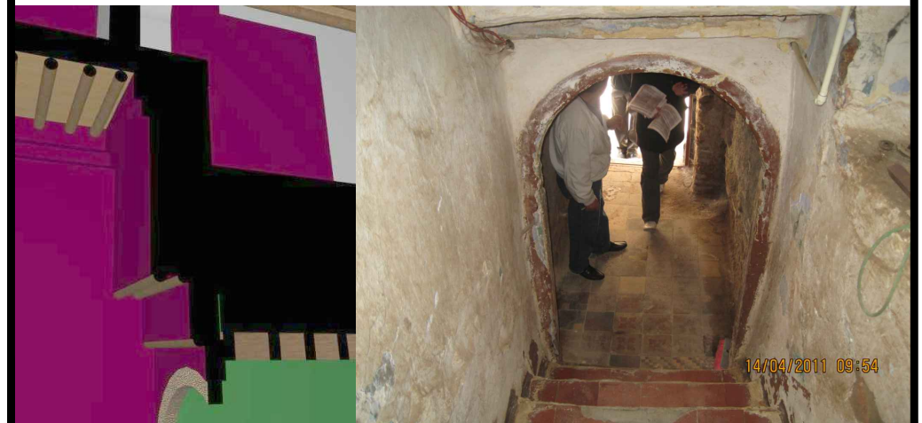
31 rue Benghanif :détail structurel .
