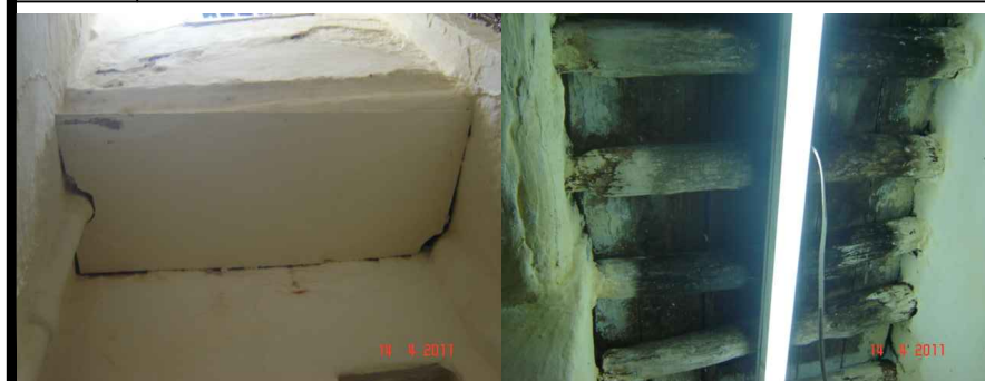
Vue sur le plancher du couloir .
