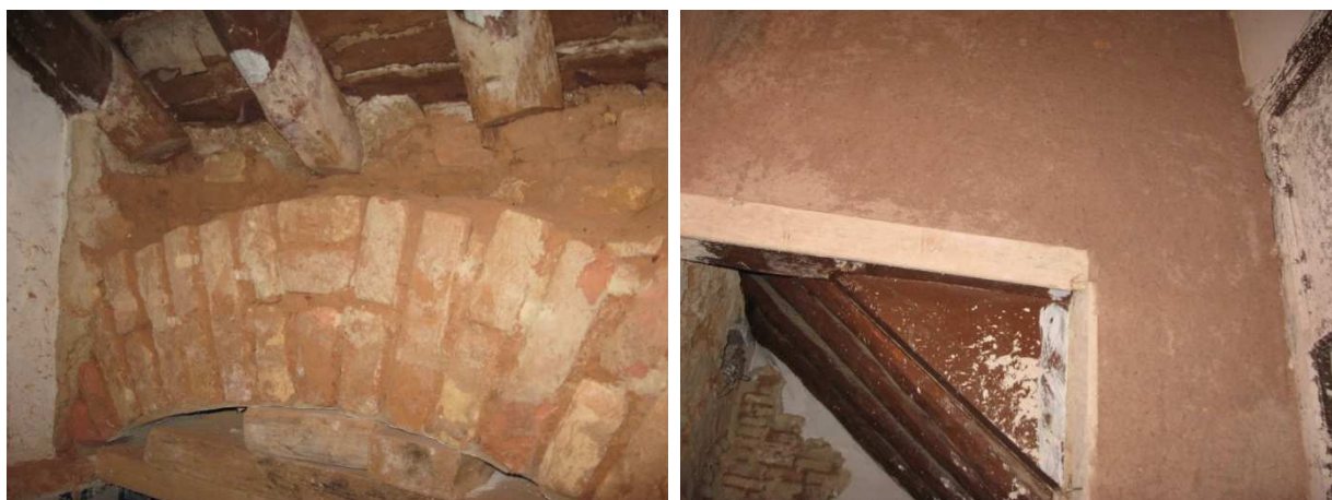
Photo 15 : La structure de l'escalier d'honneur de Djnen Lakhdar 264 .
