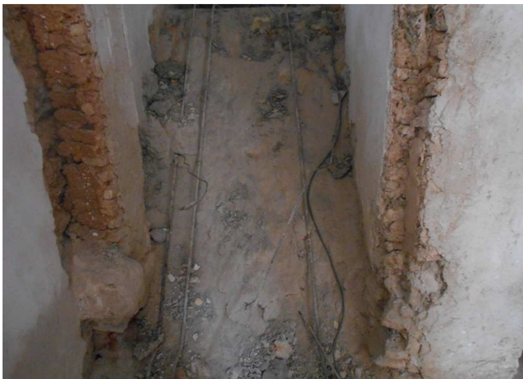
Photo 5 : L'escalier du Hammam des janissaires avant la dépose du béton armé 219 .
