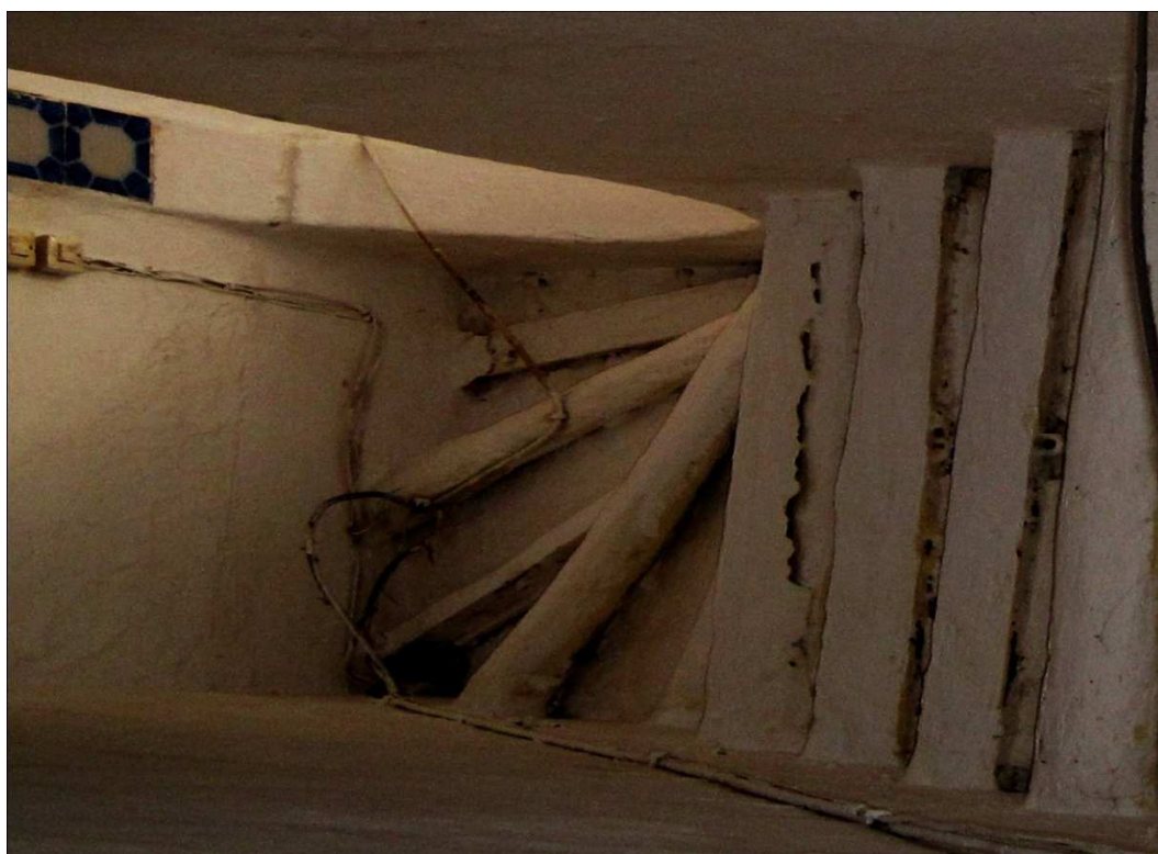
Photo 13 : Le balancement structurel de l'escalier du spécimen N°10 260 .
