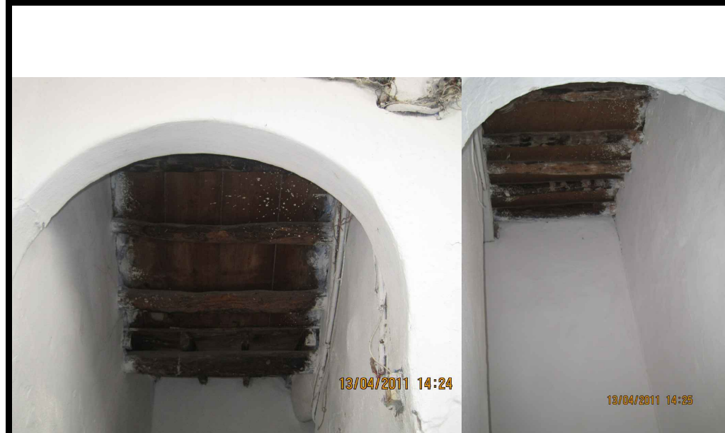
La structure du volume d'escalier.
