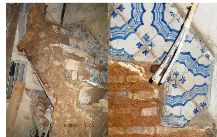
les carreaux des contre-marches et des plinthes.
