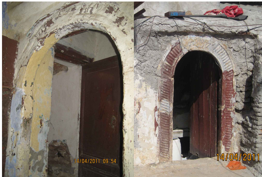
N°31 rue Benghanif: Chambranles en tuf
