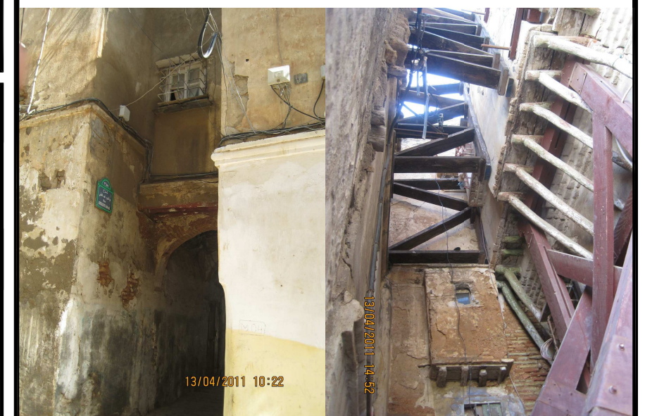
31rue Benghanif Façade Sud-Est
