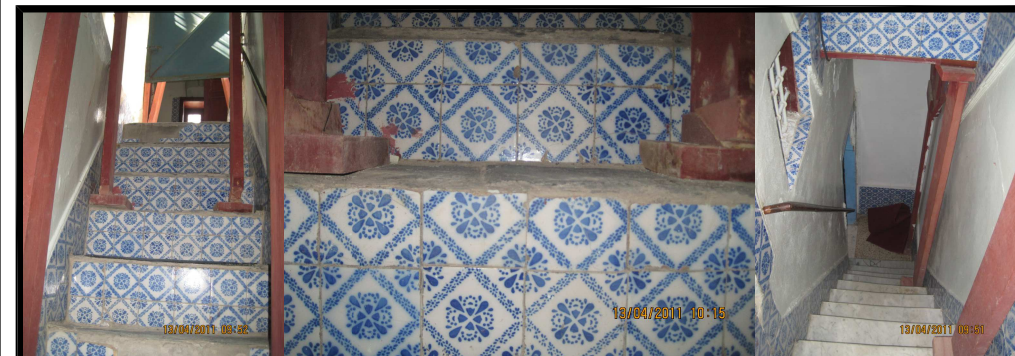
Le schiste des marches la céramique des contres-marches et des plinthes Le marbre des marches
