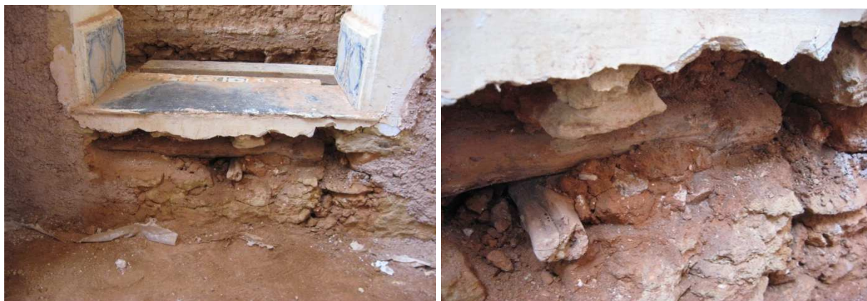
Photo 26 : Les rondins du seuil de la porte 295 .
