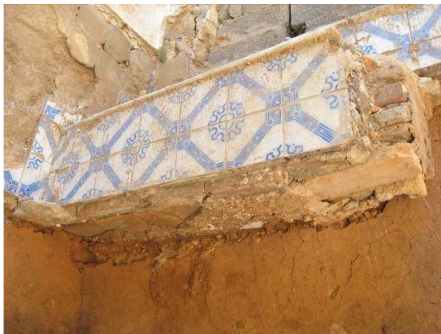
Photo10 : L'escalier de la Dar N°57 rue Rabah Riyah 228 .
