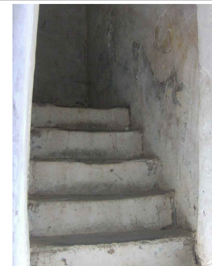
les revêtements de l'escalier.
