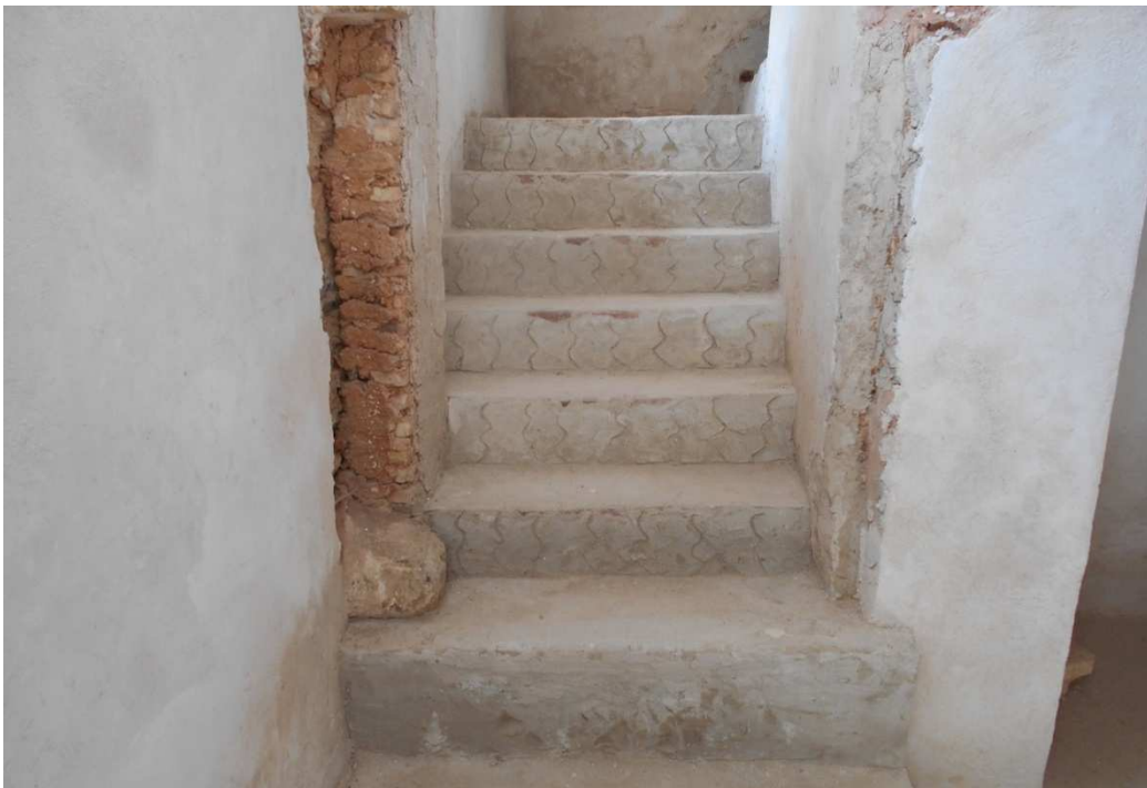
Photo 5 : les marches reconstruites en maçonnerie traditionnelle 222 .
