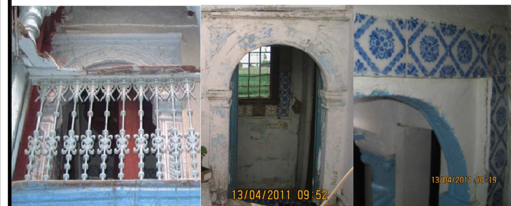
Chambranles des portes.
