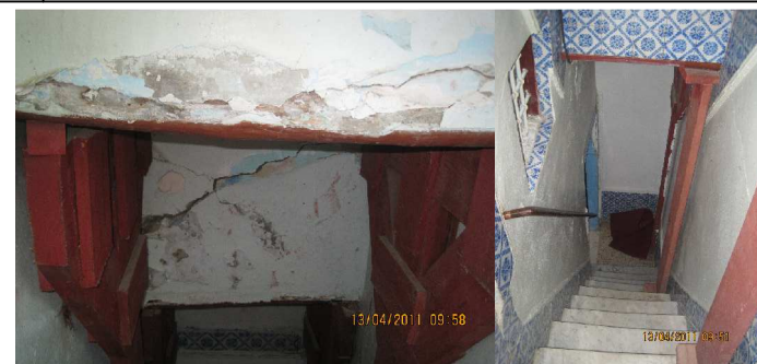
Vues sur les estrades de l'escalier.
