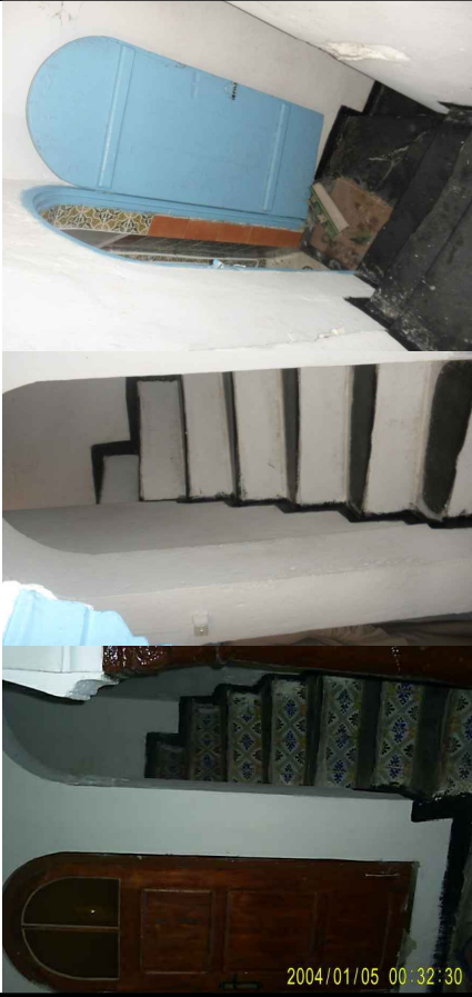
les revêtements de l'escalier.
