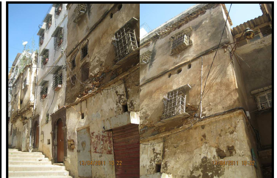
31/33 rue Benghanif Façade Sud-Ouest
