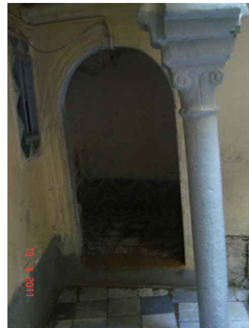
le chambranle du RDC.
