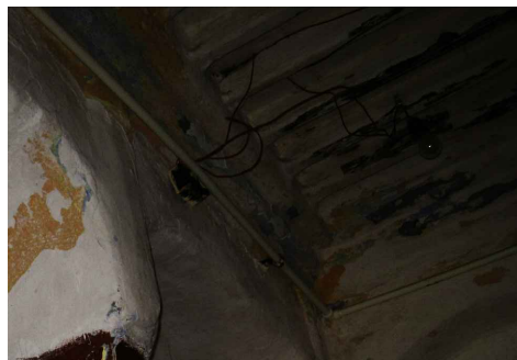
N° 31 rue Benghanif: les gorges en plâtre.
