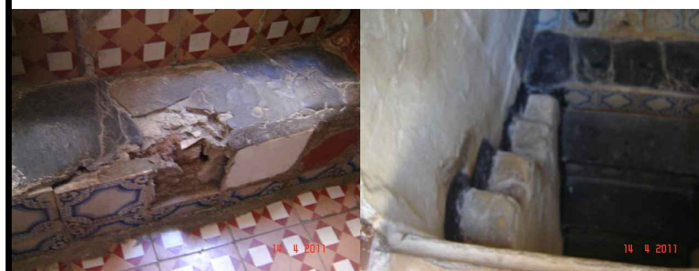
Le schiste des marches et la céramique des cotremarches
