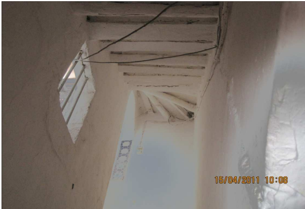
Photo 11 : structure mixte (solives: rondins) des estrades 246 .
