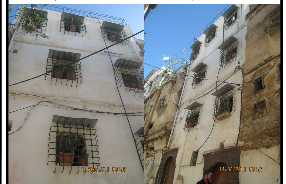
33rue Benghanif Façade Sud-Ouest
