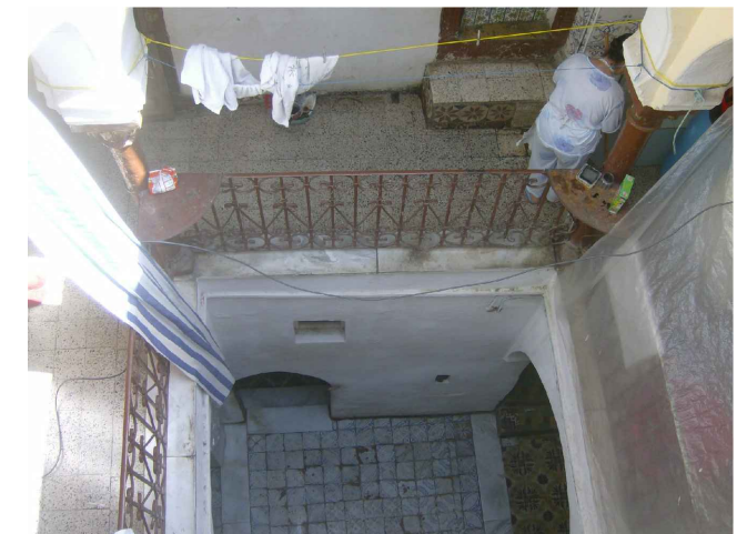
les revêtements de l'escalier.
