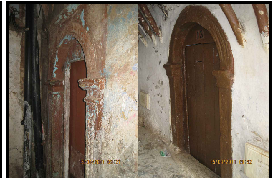
13 & 15 impasse des frères Belhimer. Façade Sud.
