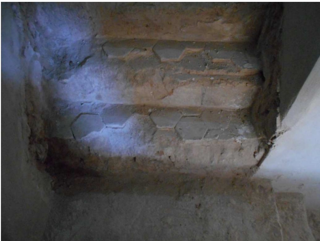
Photo 6 : Les marches authentiques de l'escalier du Hammam des janissaires 223 .
