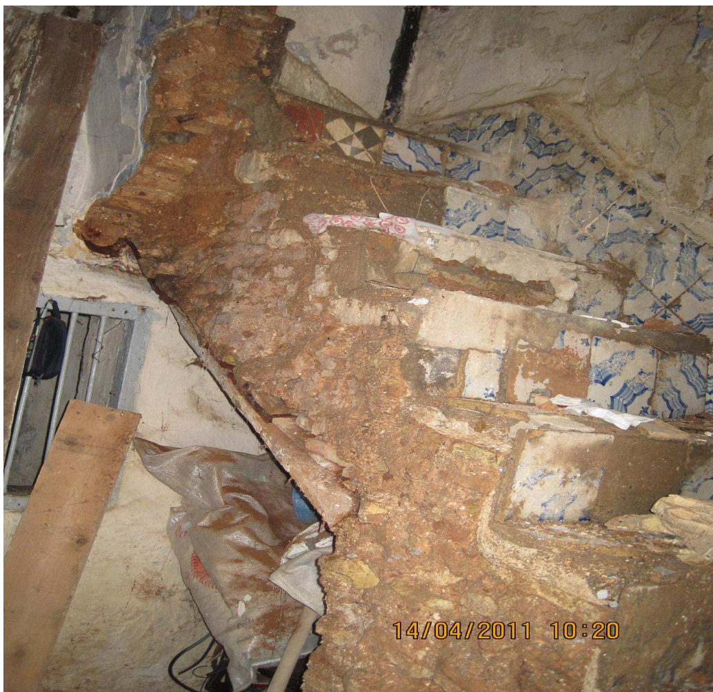
Photo 14 : Les rondins porteurs inclinés 262 .
