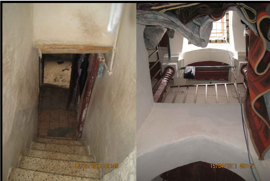
L'escalier de l'entrée.
