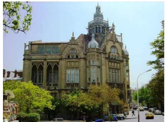
Figure 6.8 : confortement du palais Mukhtarov par le système DC 90.
