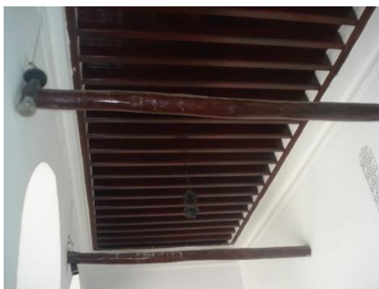
Figure 5.20 : vue les rondins d'un plancher de la villa. Source : l'auteur.
