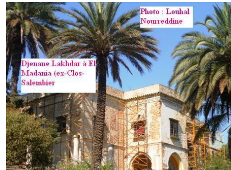
Figure 5.12 : vue sur la maçonnerie des murs de la villa avant réhabilitation.
