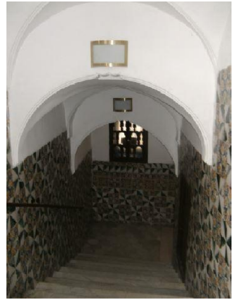
Figure 3.10 : voûte en berceau recouvrant un escalier.
