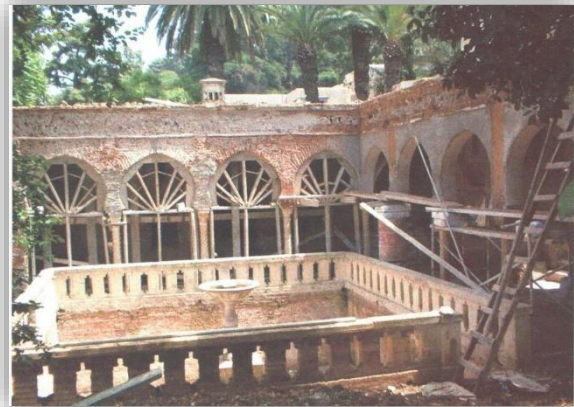
Figure 5.25 : vue sur un portique de la villa en cours de réhabilitation.
