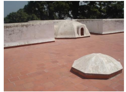
Figure 5.22 : vue de la toiture terrasse et des coupoles qui couvrent les planchers de la villa. Source : l'auteur.
