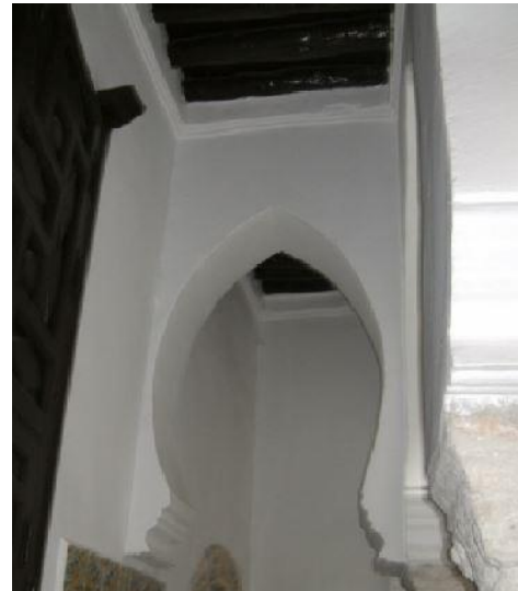
Figure 3.3 : arc en ogive de contreventement Source : ACHAB Samia Ep CHERNAI (juin 2012)
