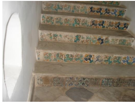
Figure 5.16 : vue sur un revêtement d'escalier après réhabilitation de la villa. Source : l'auteur.
