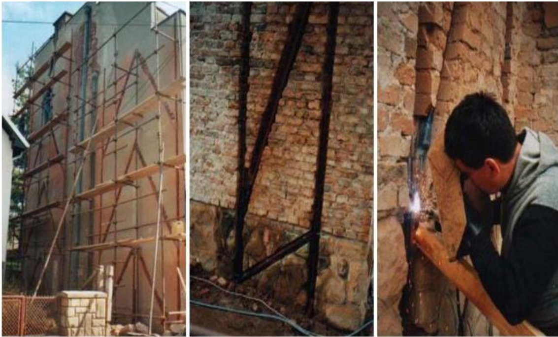
Figure 6.7 : confortement d'un immeuble de logement par le système DC90. Source : site officiel entreprise DC 90.
