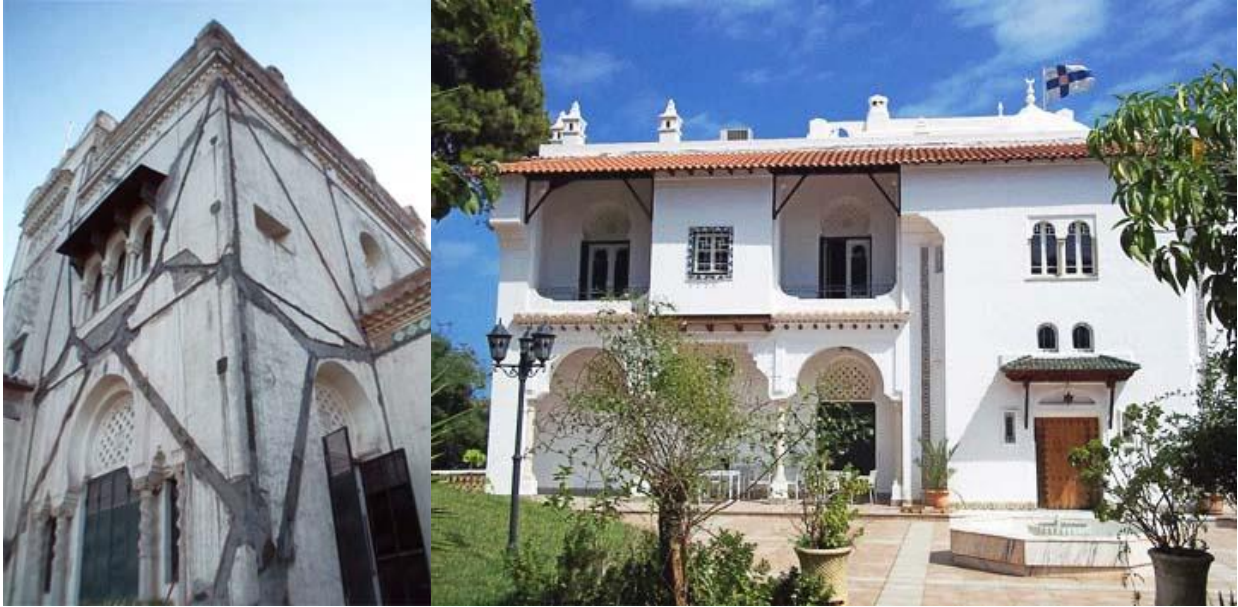
Figure 6.9 : confortement de la résidence de l'ambassade finlandaise à Alger. Source : site officiel entreprise DC 90.
