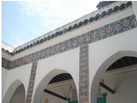
Figure 5.17 : vue sur l'enduit et les faïences des arcades extérieures après réhabilitation de la villa. Source : l'auteur.
