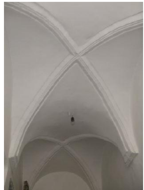
Figure 3.11 : voûte d'arête recouvrant un escalier.
