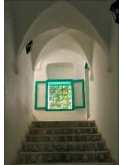
Figure 5.24 : vue sur un escalier vouté. Source : l'auteur.
