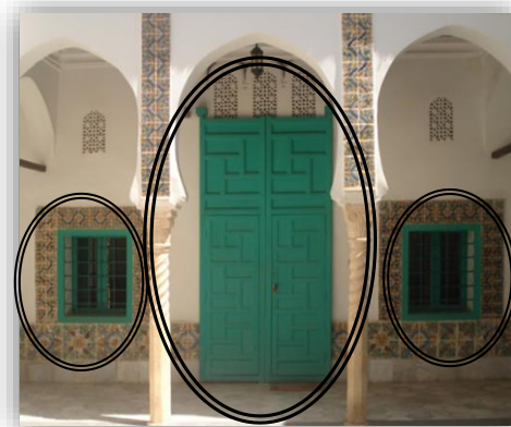
Figure 5.13 : vue sur des ouvertures après réhabilitation de la villa.
