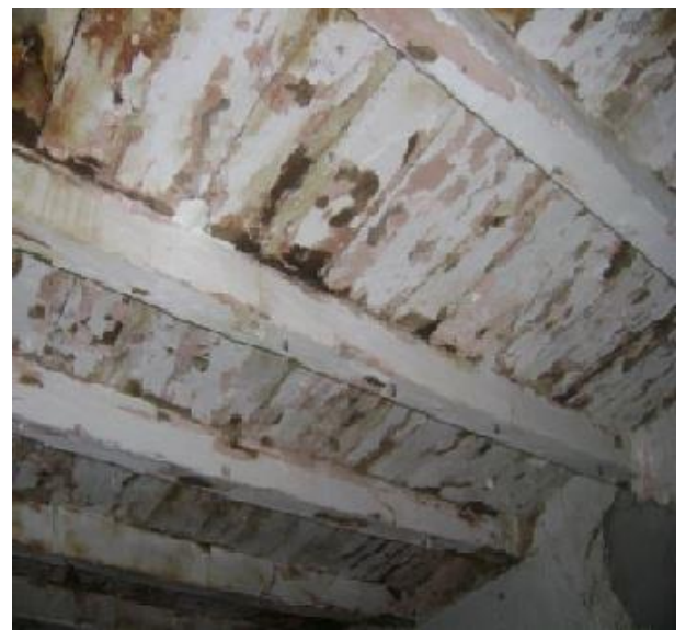
Figure 3.9 : plancher sur solives équarrées et voligeages.
