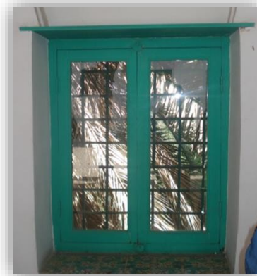
Figure 5.14 : vue sur fenêtre après réhabilitation de la villa.
