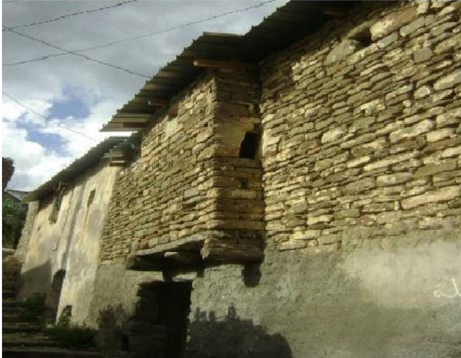
Figure 3.1 : mur hourdé en appareillage de pierre, casbah de Dellys. Source : ACHAB Samia Ep CHERNAI (juin 2012)
