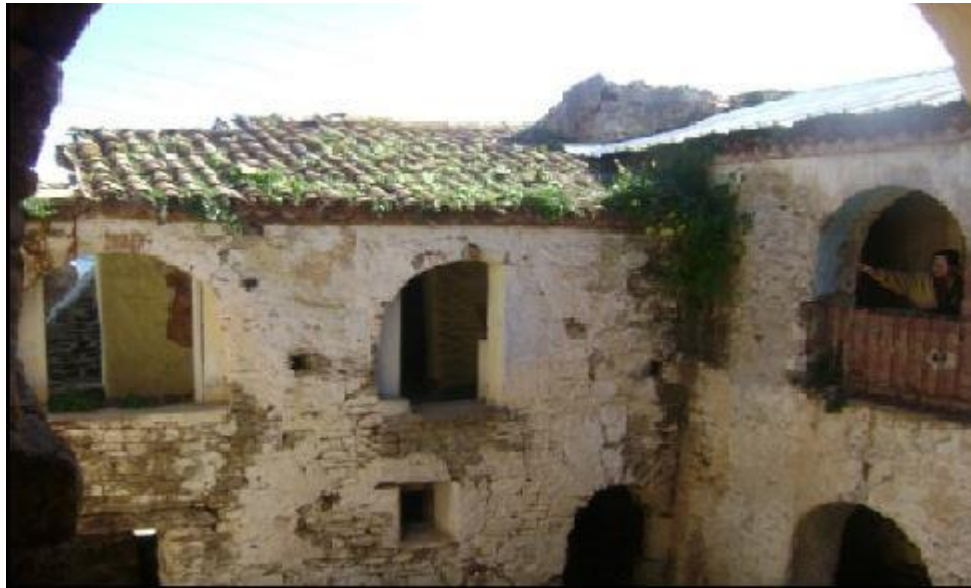
Figure 3.13 : une charpente simple portant de la tuile canal. Source : ACHAB Samia Ep CHERNAI (juin 2012)
