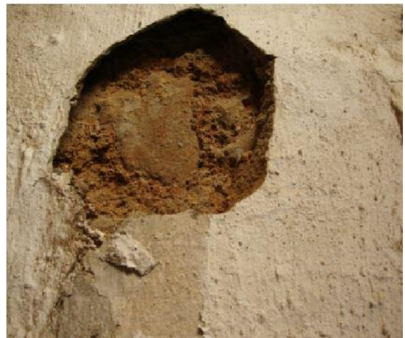
Figure 3.17 : enduit à base de terre argilo-sableuse et chaux.
