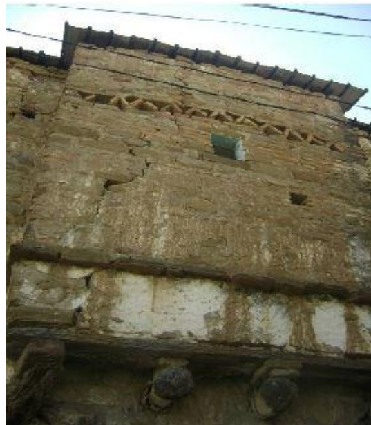
Figure 3.20 : fissure dans un mur en maçonnerie.
