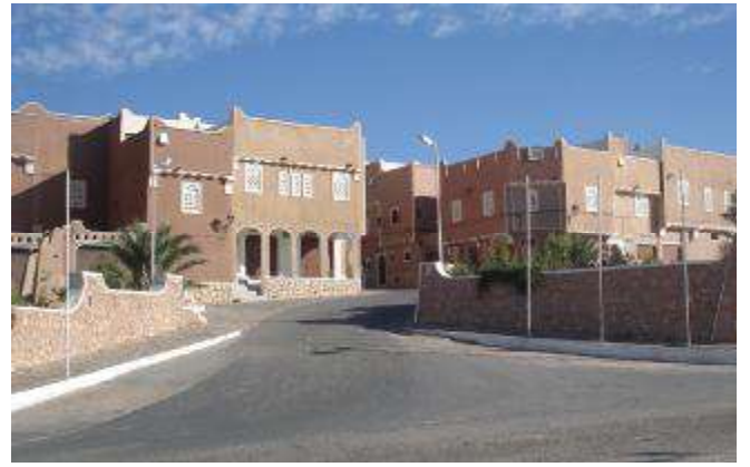
Quartier en cours de construction, zone de l'Aéroport de Ghardaïa
