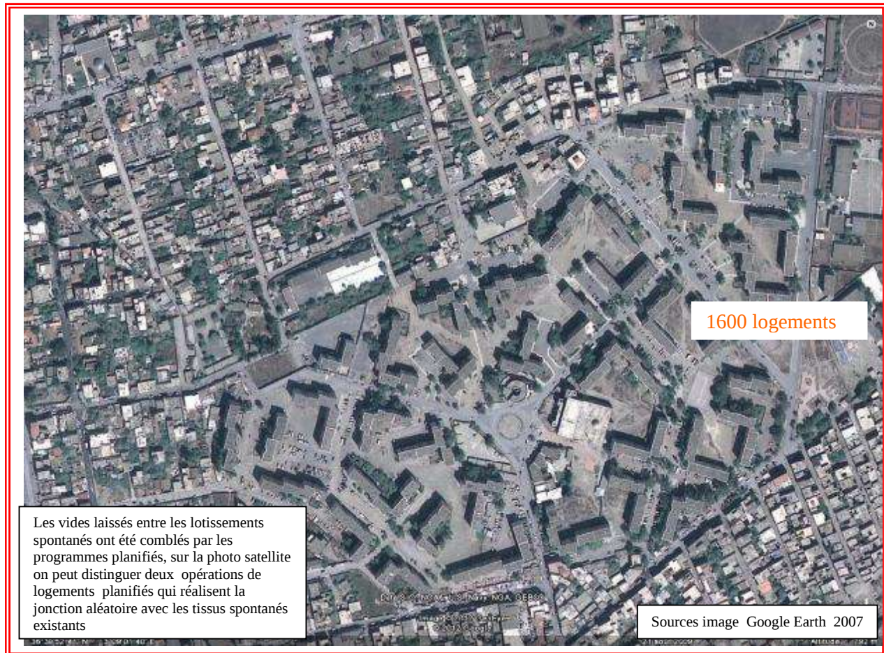
Figure N°49 DISCONTINUITES ENTRE QUARTIERS PLANIFIES ET SPONTANES, EUCALYPTUS 2007
