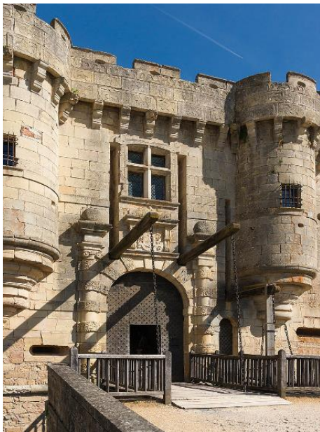
Figure 18 : Pont-levis à flèches et à chaînes du Château de Hautefort en Dordogne. Source : wikipedia.org.
