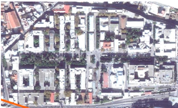
Photo 4 : Image aérienne à haut résolution, l'hôpital Mustapha, Source : PRU, (2014-2017)
