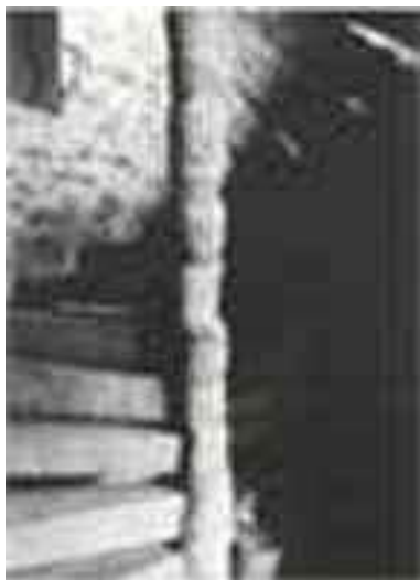
Figure 2 : Escalier à empilement de marches massives rayonnantes 13
