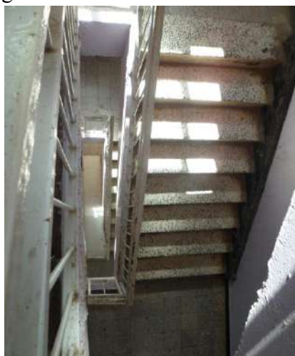
Photo 4 : La cage d'escalier du bloc 25 Rabia T. Bab-Ezzouar. Alger (par l'auteur)
