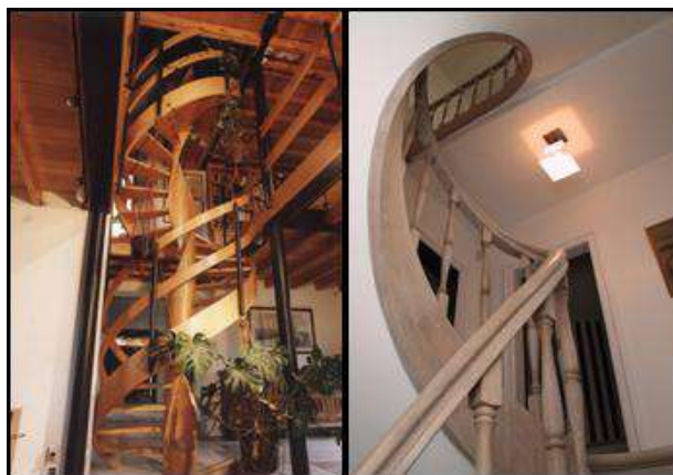
Figure 5 : Escaliers hélicoïdaux classiques avec noyau évidé elliptique. Source :
