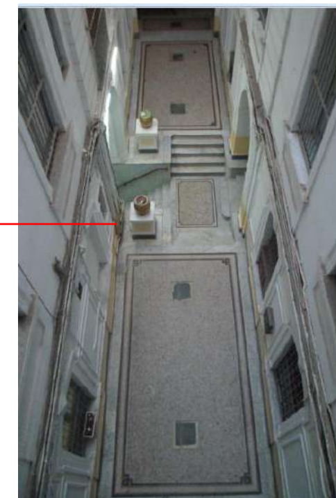
L'atrium de l'immeuble (par l'auteur)
