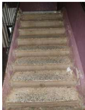
La cage d'escalier Bloc 25 Rabia
