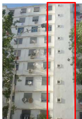
L'emplacement de la cage d'escalier sur la façade
