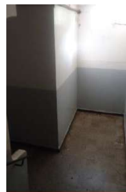
Photo 24 : ventilation par petite ouvrant (Barre sans coursive, les Annassers (par l'auteur)
