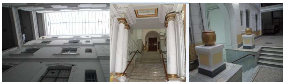
Photo 6 : Immeuble n°37, rue Larbi Ben M'hidi (Prise par l'auteur)
