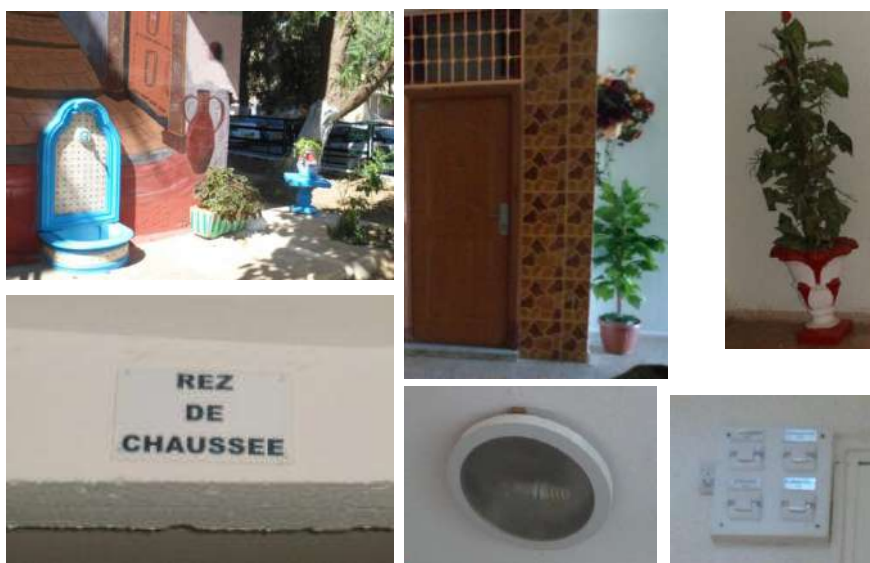
Photo 14 : quelques modifications apportées sur l'immeuble 26 Rabia .T (prise par l'auteur)
