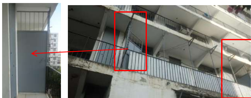
Photo 20 : les portes séparatrices de la coursive de la cité des Annassers
