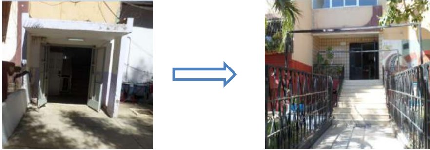
Photo 10 : Cage d'escalier B 25 Rabia. T(à gauche) , Hall entrée B 26 (à droite)
