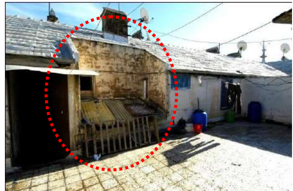
Photo 53 : Détail de couverture sur courette donnant sur cuisine, (Source : L Adolphe)
