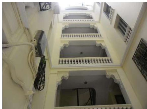
Photo 28: Paliers de distribution des appartements, (Source : Auteur)
