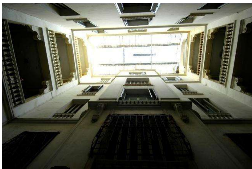
Photo 23 : Immeuble 4 , Cas d'étude : 39 Rue Larbi Ben M'Hidi, (Photo : L Adolphe)
