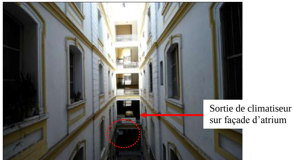
Photo 24: Sortie de climatiseur sur façade d'atrium, immeuble n°3, (Photo : L. Adolphe)
