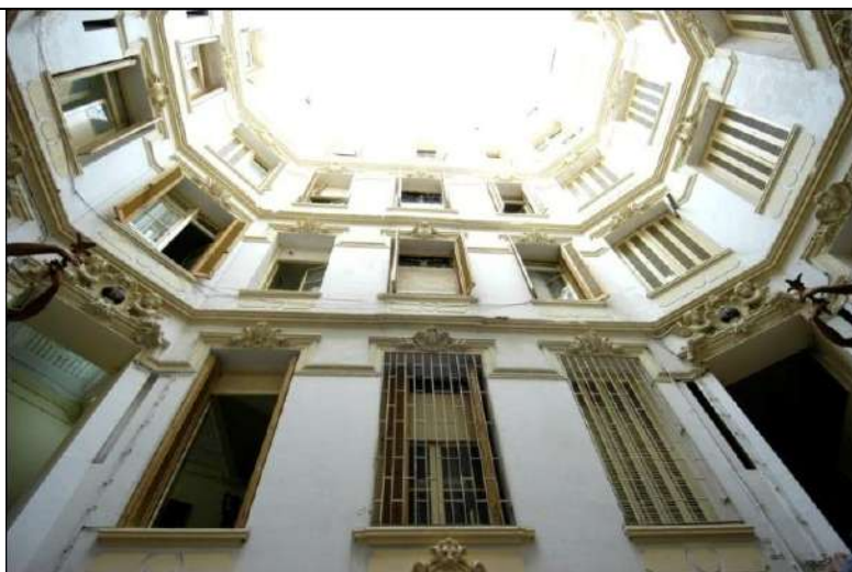
Photo 20 : Immeuble 1 , 12 Rue Ali Boumendjel, (Ex Dumont Durville), (Photo : L Adolphe)
