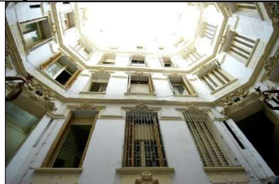
Photo 8 : 12 rue A. Boumendjel, (Source : L. Adolphe).
