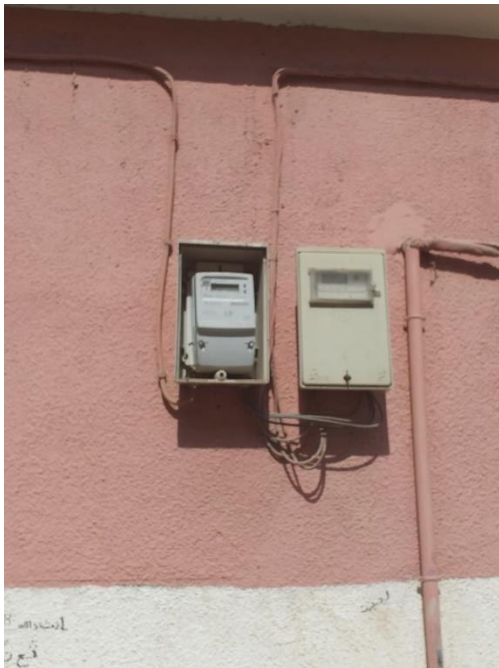
Figure 30,31, 32 et 33 : Les smart meters installés au sein du quartier de Diar El Bahri
