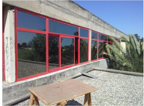
Figure 25: Vitrages réfléchissants utilisés actuellement au niveau des ateliers (de l'extérieur). Source Auteur
