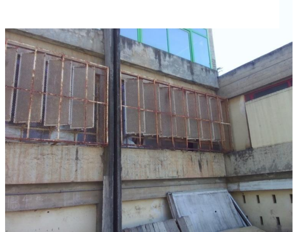
Figure 27: Modèle de l'ancien brise soleil utilisé au niveau des ateliers (de l'extérieur) . Source Auteur
