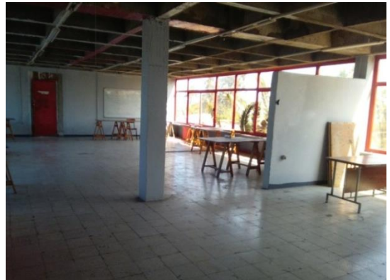
Figure 33 : Vue 4 à l'intérieur de l'atelier 322. Source Auteur.
