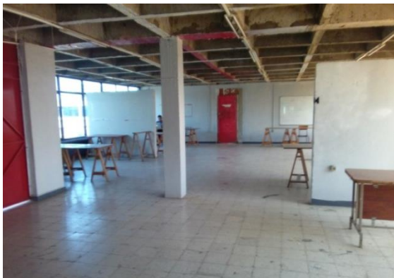
Figure 34 : Vue 3 à l'intérieur de l'atelier 322. Source Auteur.
