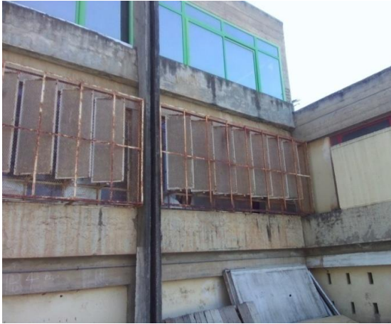
Figure 59: Les anciens brises soleil utilisés au niveau des ateliers. Source Auteur
