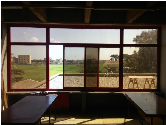
Figure 26 : Vitrages réfléchissants utilisés actuellement au niveau des ateliers (de l'intérieur) . Source Auteur
