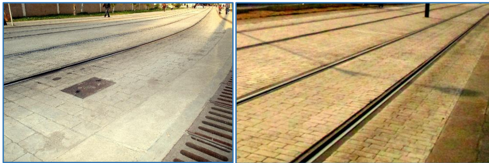
Plateforme du tramway d'Alger
