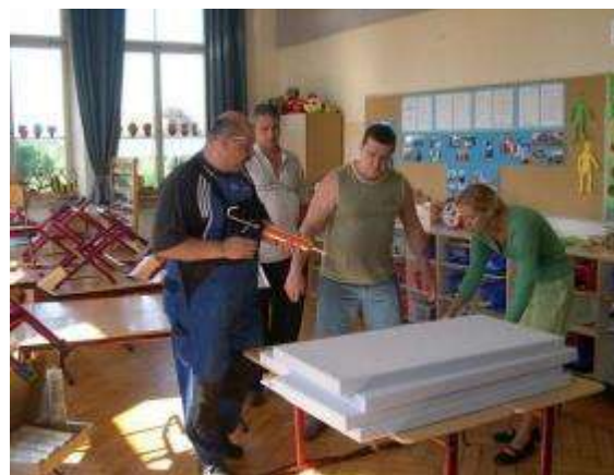
Figure 430 : Collage de panneaux absorbants avec une apparence légèrement inférieure.
