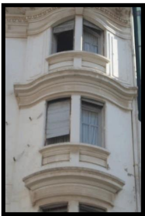
Figure 11 : moulure de l'immeuble N:16. Rue Larbi Ben M'hidi 91
