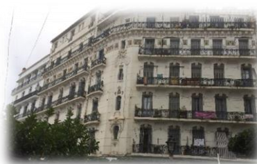
Fig46 : façade de l'Immeuble n°59 : rue Larbi Ben M'hidi (source : auteure 2018)
