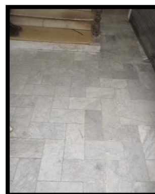
Fig69 : marbre refait du sol (source : auteure 2018)
