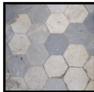
Fig60 : carreau de marbre du sol (source : auteure 2018)
