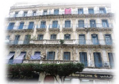
Fig40 : façade de l'Immeuble n°12 : rue Ali Boumendjel (source : auteure 2018)
