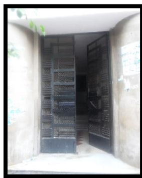
Fig144 : porte d'entrée en ferronnerie (source : auteure 2018)
