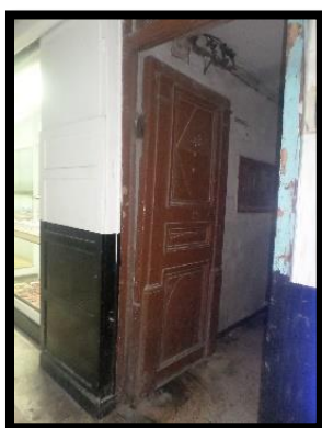
Fig63 : porte d'entrée de l'immeuble, très modeste avec un seul vantail (source : auteure 2018)
