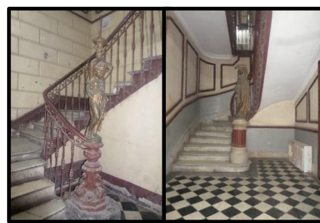
Fig89 : départs des rampes d'escaliers ornés d'anthropomorphes (source : auteure 2018)
