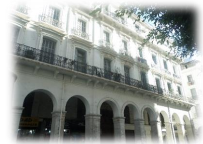
Fig38 : façade de l'Immeuble n°14 rue Abane Remdane (source : auteure 2018)
