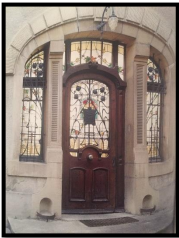
Figure 15 : La transparence à travers la ferronnerie d'une porte d'immeuble 114
