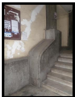
Fig129 : murs perrons du hall en granito lustré (source : auteure 2018)
