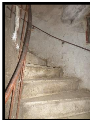
Fig64 : escalier à quartiers tournants (source : auteure 2018)
