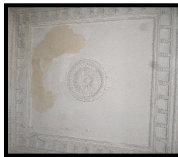
Fig98 : plafond refait en moulures et rosace de plâtre (source : auteure 2018)
