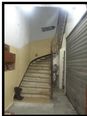
Fig66 : hall d'entrée à partir du passage commercial de l'Immeuble a passage : Place des martyres (source : auteure 2018)
