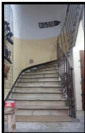
Fig68 : garde-corps en fer forgé (source : auteure 2018)
