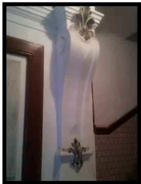
Fig121: pilastre galbé (source : auteure 2018)
