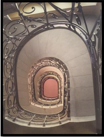
Figure 16 : Vue en contre plongée d'une cage d'escalier montrant un imposant garde corp en fer forgé 115
