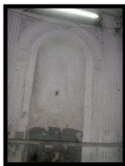
Fig56 : niche encadré de deux pilastre (source : auteure 2018)
