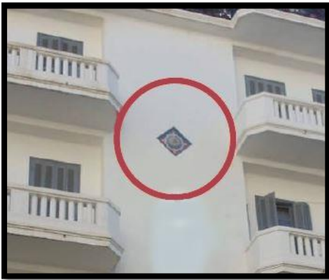
Figure 14 : ornement Industriel de l'immeuble N:60. Rue Larbi Ben M'hidi 104
