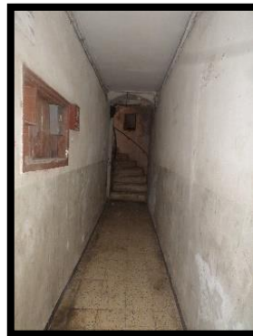
Fig62 : couloir d'entrée de l'immeuble n°13 : rue Bab Azoun (source : auteure 2018)
