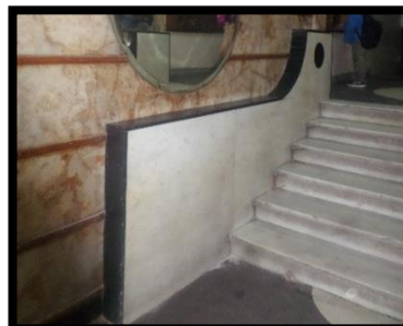
Fig137 : marbre noir et blanc du soubassement (source : auteure 2018)
