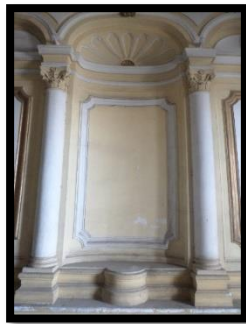
Fig76 : niche au milieu du mur (source : auteure 2018)
