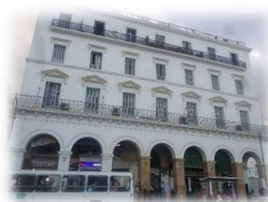
Fig34 : façade de l'immeuble à passage Place des martyres (source : auteure 2018)
