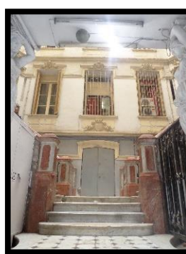
Fig100 : palier d'embranchement des 04 rampes d'escalier (source : auteure 2018)
