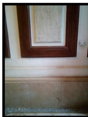
Fig120: Soubassement en marbre ocre et panneau encadré en bois (source : auteure 2018)
