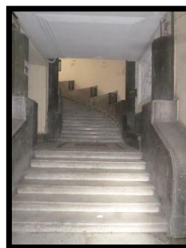
Fig127 : l'escalier monumental du hall d'entrée d'Immeuble n°94 : rue Didouche Mourad (source : auteure 2018)
