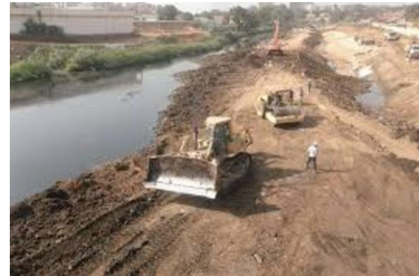
Figure 52: Début des travaux de restructuration de l'oued
