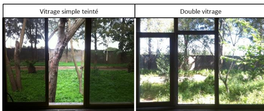
Figure 60 Différence de la teinte entre les deux types de vitrage
