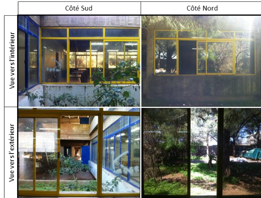
Figure 53 : Différence perçue de la teinte entre vitrages du côté Nord et Sud
