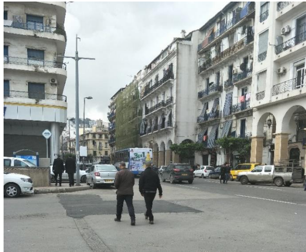
Figure 60 La variété des percés et façades au niveau de la station 3
