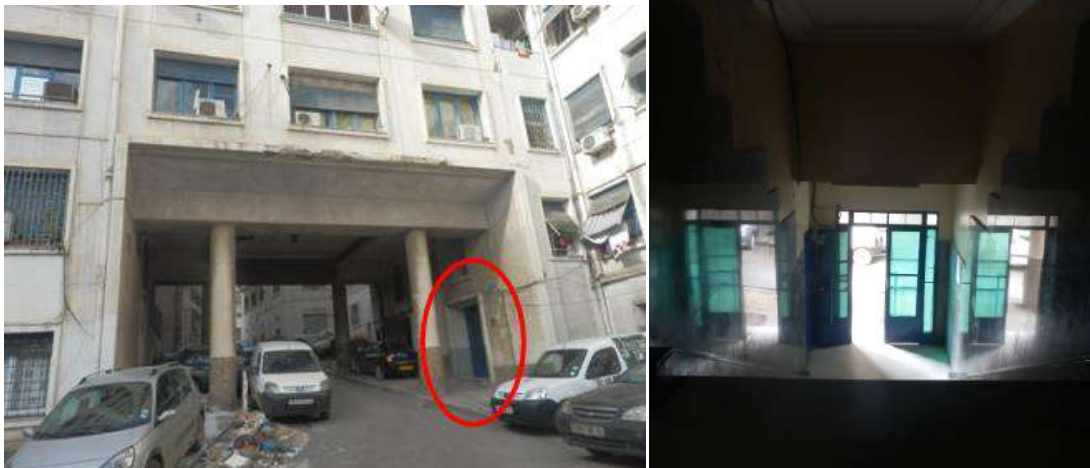
Fig. 215 Accès du bâtiment H.
