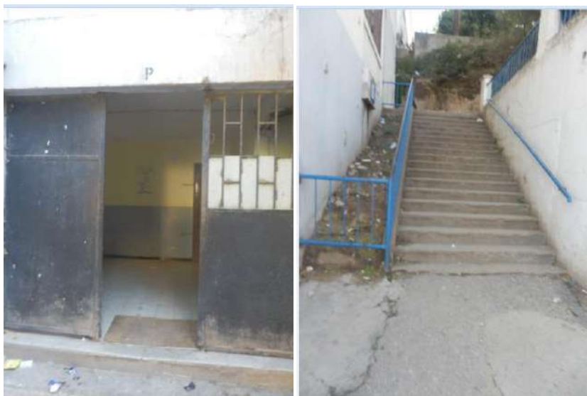
Fig.334 Entrée au premier étage Fig.335 Vue sur l'escalier extérieur Source : Auteur, 2014.
