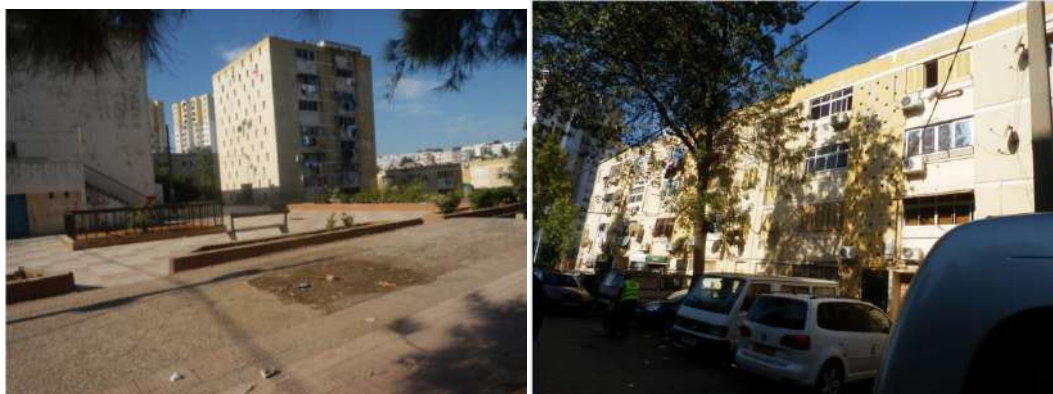
Fig.327 Vue sur la tour Source : Auteur, 2014.
