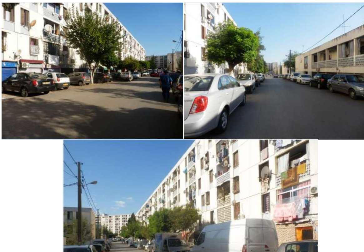
Fig.367 Vue sur le traitement de façades de l'ensemble de la cité.
