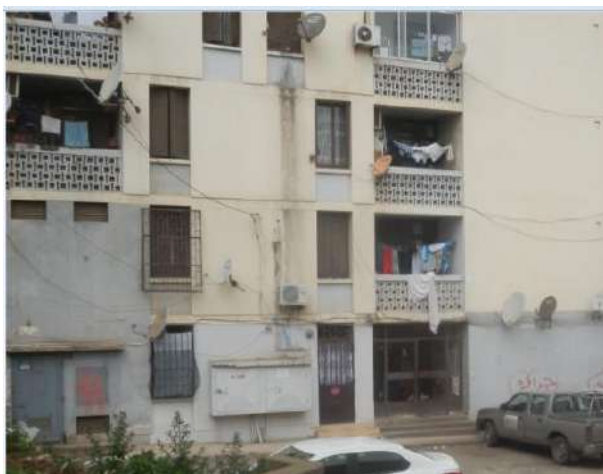
Fig.333 Entrée au RDC. Source : Auteur, 2014.
