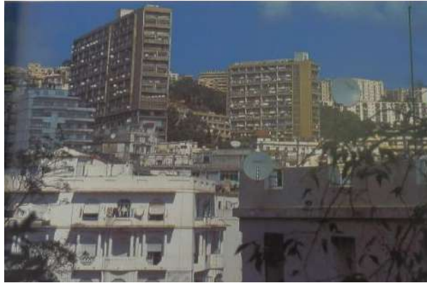
Fig. 167 Vue sur les bâtiments composant l'Aéro Habitat
