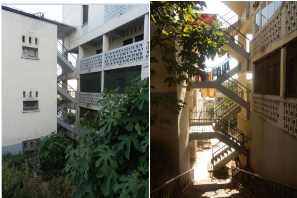
Fig.319 Vue sur les deux Bâtiments reliés par l'escalier.
