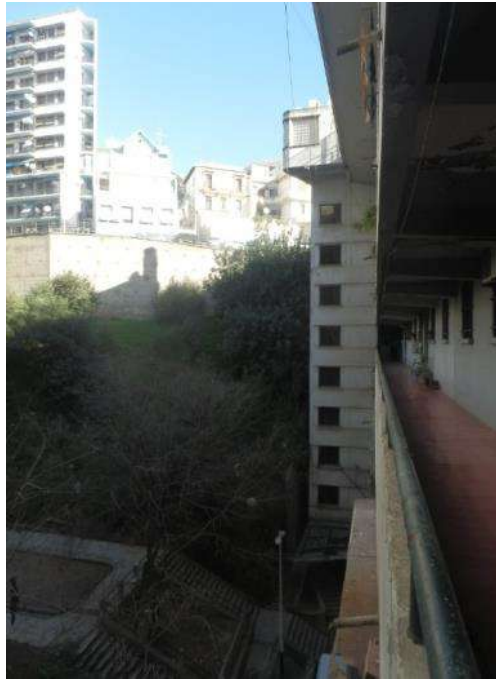
Fig. 253 Vue sur le volume qui abrite la cage d'escaliers.
