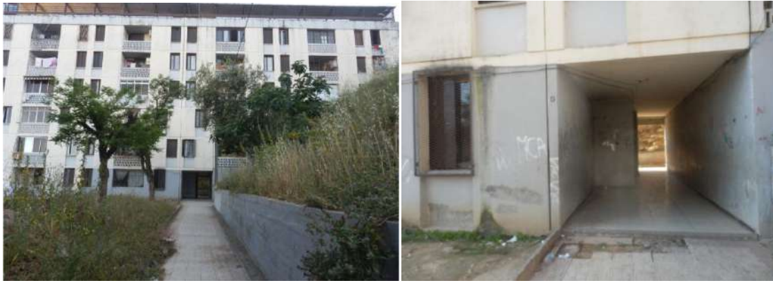
Fig.324 Vue sur le bâtiment et l'entrée du passage.
