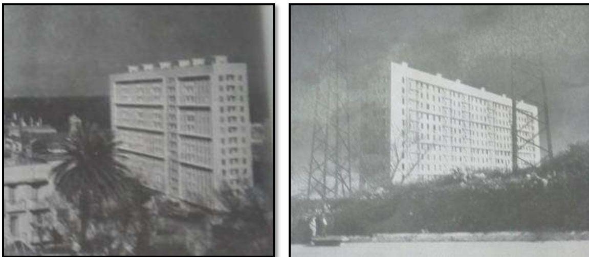
Fig. 239 Façade Nord Ouest
