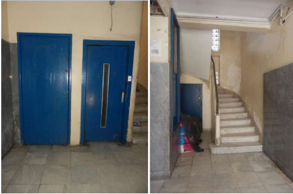
Fig. 218 Vue sur la cage d'escalier et l'ascenseur
