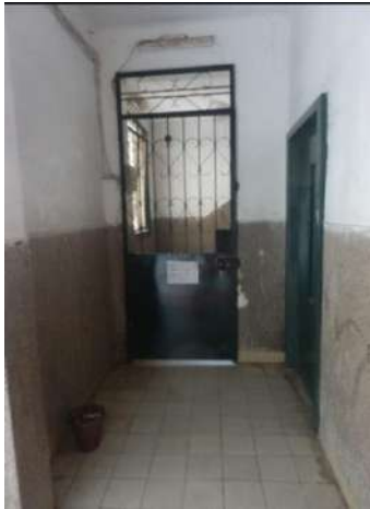
Fig. 266 Porte qui sépare la cage d'escalier du hall d'aboutissement de l'ascenseur.
