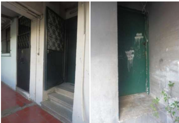
Fig. 270 Portes d'accès aux logements
