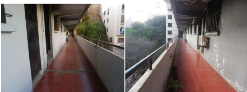
Fig. 268 Vue sur la coursive.
