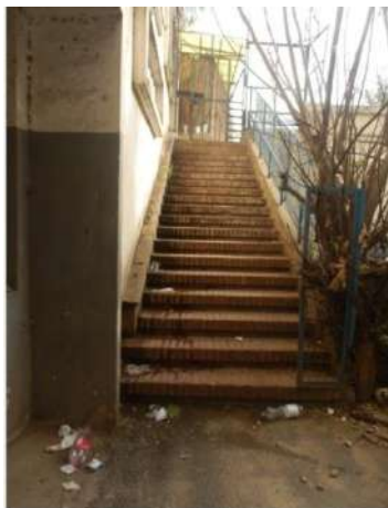
Fig. 213 Escaliers menant vers la terrasse du garage
