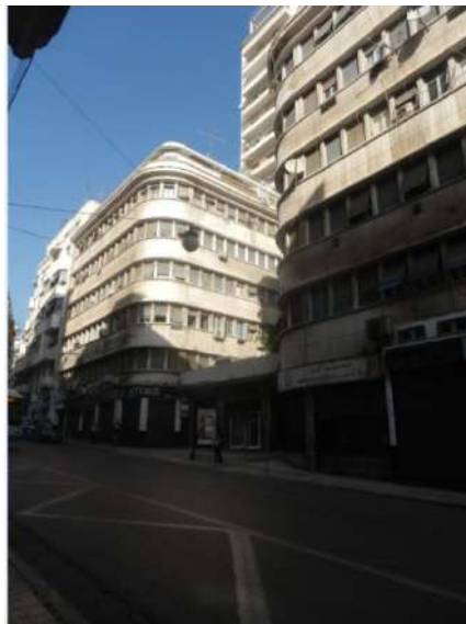
Fig. 230 La façade du côté de la rue Didouche Mourad.
