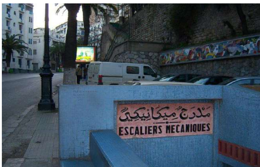
Fig. 3 Les escaliers mécaniques, Boulevard Mohamed V.
