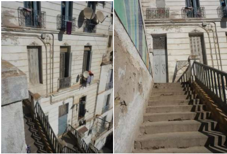
Fig. 165 Façade de l'immeuble
