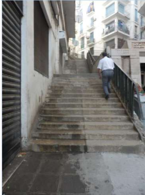
Fig. 229 Escalier public qui relie la rue Didouche Mourad au Boulevard Mohamed V. Source : Auteur, 2014.
