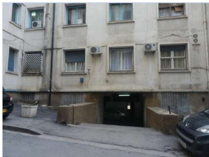
Fig. 205 Garage au niveau du sous sol du bâtiment D . Source : Auteur, 2014.
