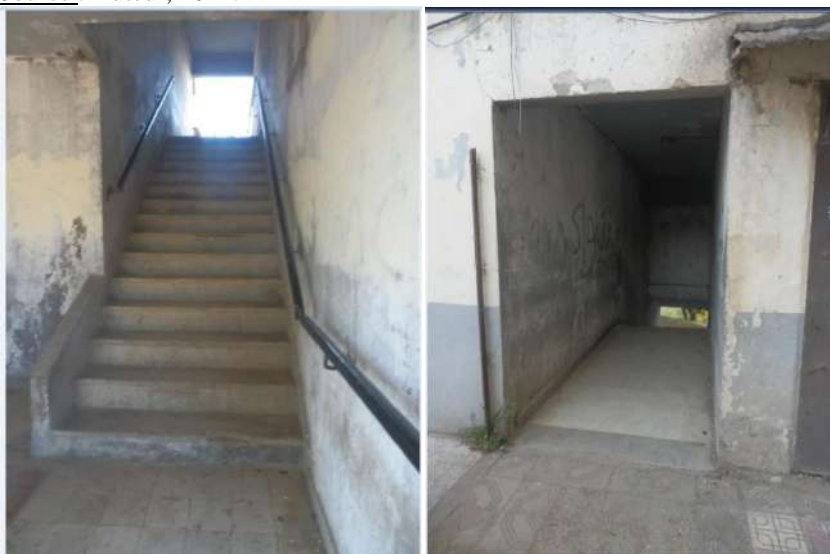
Fig.360 Vue sur l'escalier
