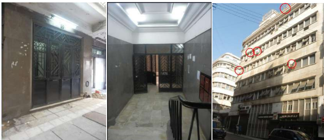
Fig. 190 Porte d'entrée du bâtiment B fermée
