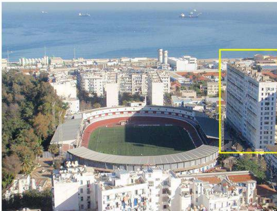
Fig. 237 Le bâtiment et son environnement immédiat.
