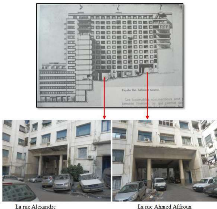
Fig. 209 Passages libérés au niveau du bâtiment F
