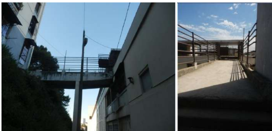
Fig.357 La passerelle vue d'en bas
