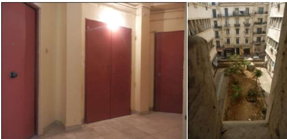
Fig. 194 Portes d'accès aux logements.
