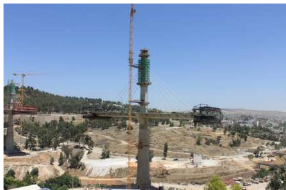
Fig. 69Le viaduc Trans-Rhummel en chantier.
