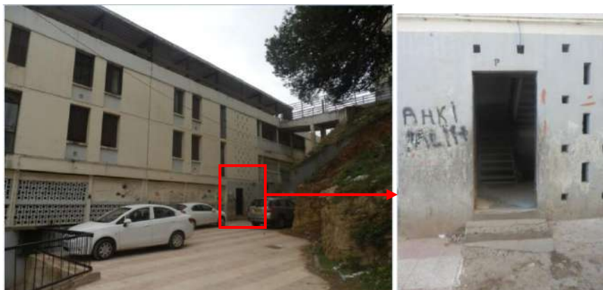
Fig.336 Vue sur la coursive du 10 e niveau et l'entrée.
