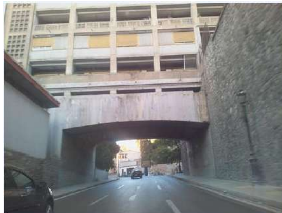
Fig. 171 Vue sur le passage en dessous de l'Aéro Habitat.
