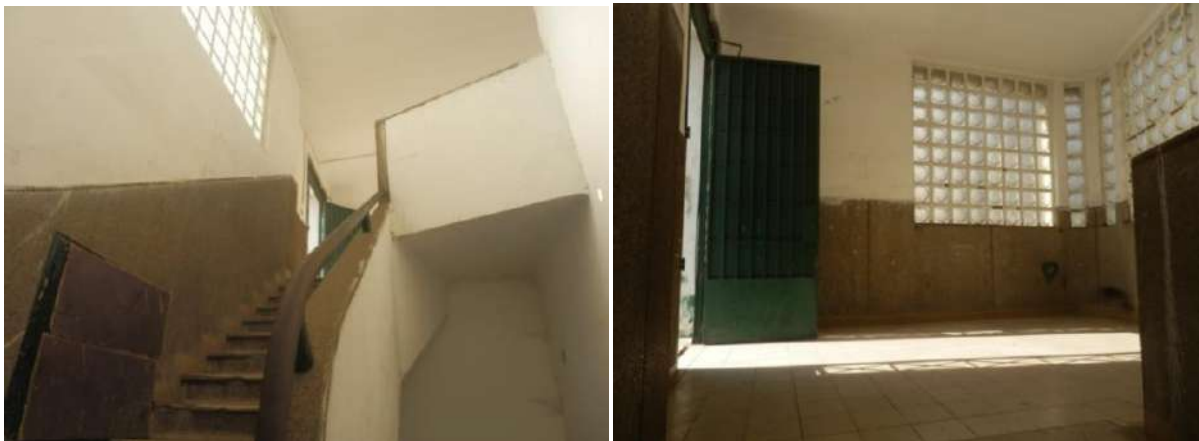
Fig. 254 Escalier menant à la terrasse du bâtiment.
