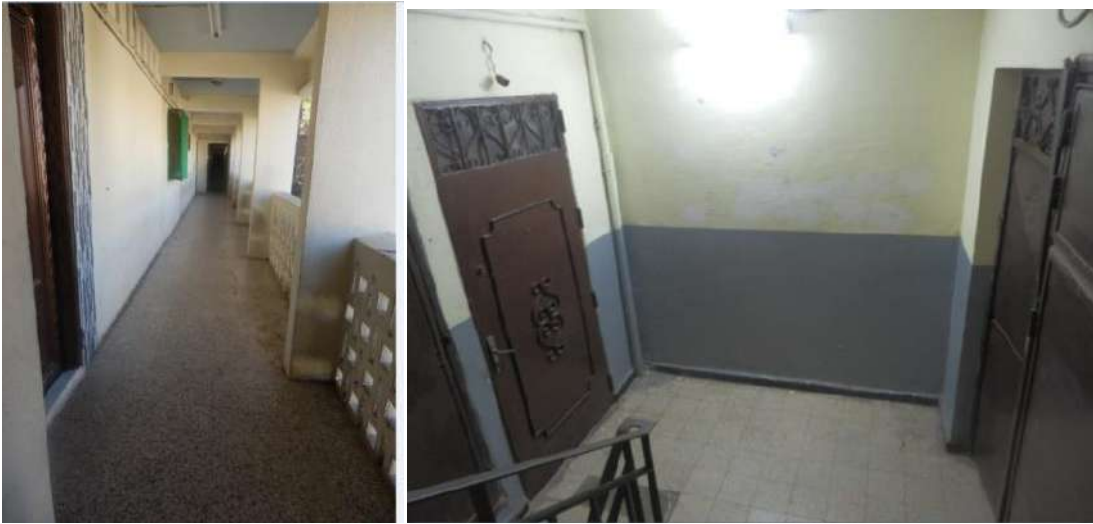
Fig.343 Vue sur la coursive du 10 e niveau.
