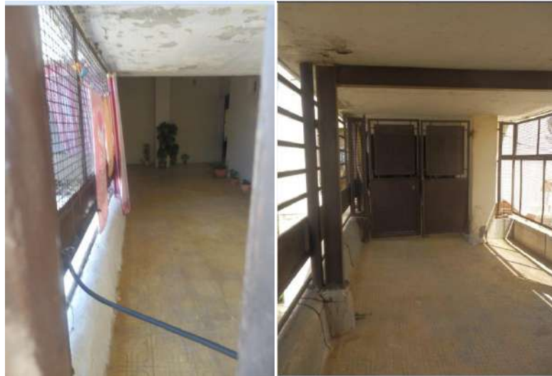
Fig.349 Vue sur le hall. Fig.350 Vue sur la porte métallique. Source : Auteur, 2014.
