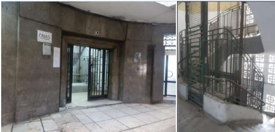
Fig. 196 Entrée du bâtiment C
