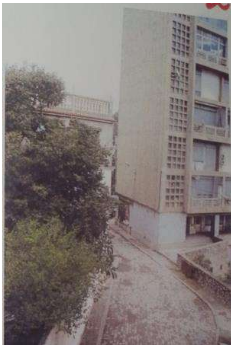
Fig. 172 Accès au 10 e étage de l'immeuble principale par la rue supérieure.
