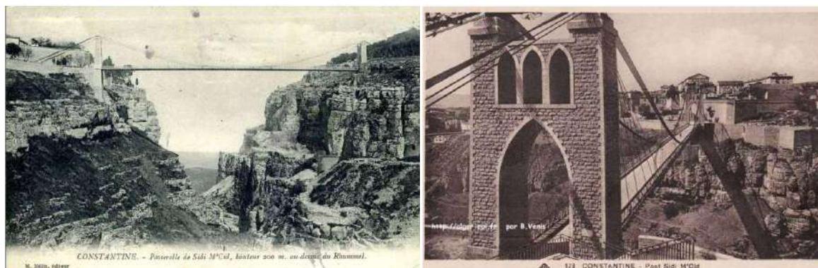
Fig. 61 Pont de Sidi M'cid.
