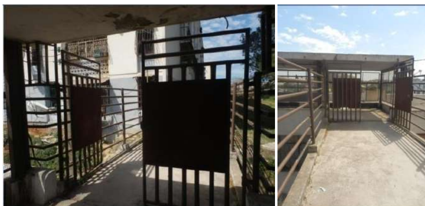
Fig.354 Sortie vers la passerelle Fig.355 Vue sur la sortie, photo prise depuis la passerelle. Source : Auteur, 2014.
