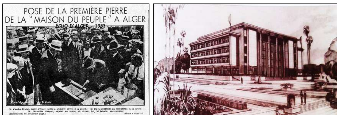
Figure 27 L'inauguration du chantier du Foyer civique et une perspective d'ensemble du projet
