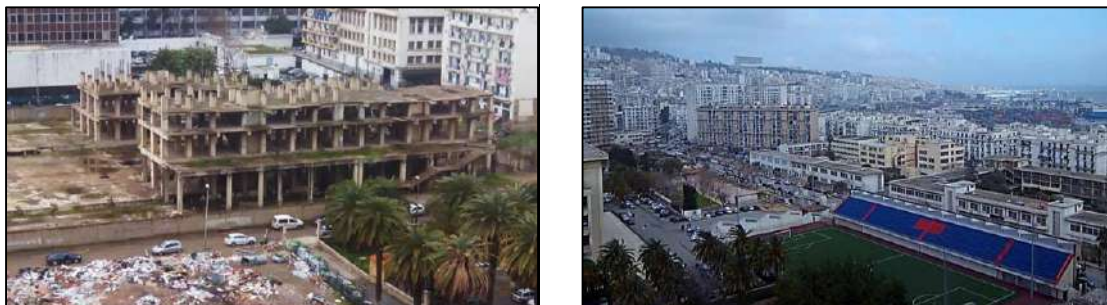
Figure 34 Chantier de la CNEP Banque et vue sur le stade et le parking du parc
