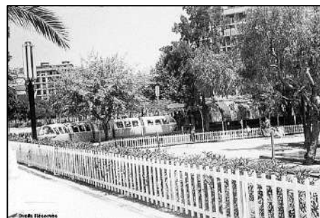
Figure 30 La gare du Montmirail
