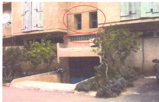
Figure 30 : Photo qui montre les ouvertures de l'extérieur (Source : Auteur, 2014)
