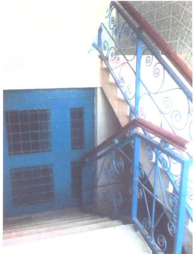
Figure 27 : Photo sur l'accès aux caves
