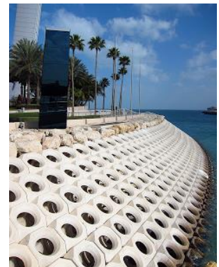
Fig. 101: Système de blocs en nid d'abeilles
