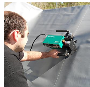
Fig.53 : Soudure de membrane
