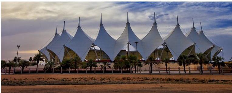
Fig. 73 : Façade du stade
