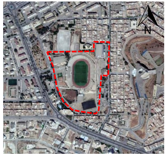
Fig.126 : Vue satellite sur le complexe sportif Zouggari
