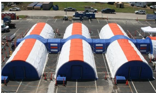
Fig. 90 : Hôpital mobile de Saint John's
