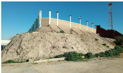
Fig. 129 : Gradins sur déblais
