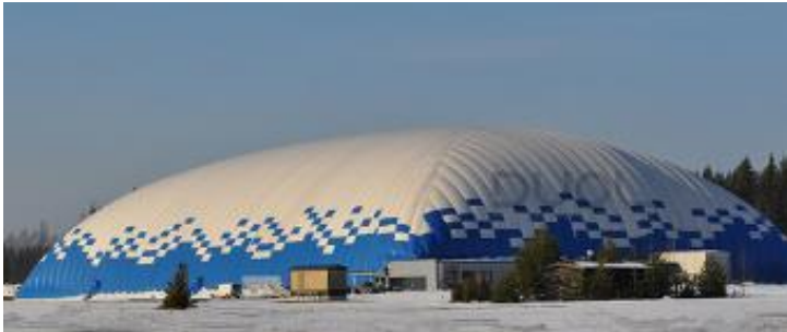
Fig.36 : Vue de l'extérieur Salle de sport à Niort. France
