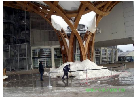
Fig. 50 : Déchirure de la toile en PTFE
