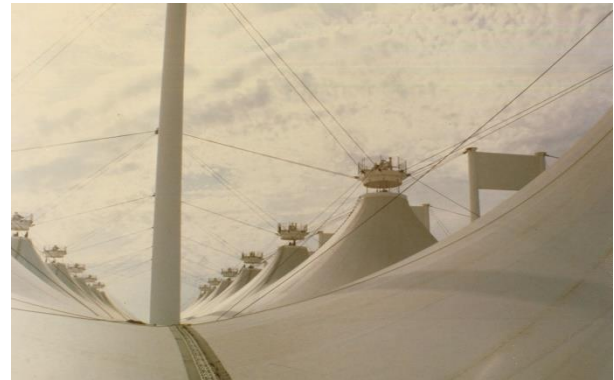
Fig. 108: système de support de la couverture
