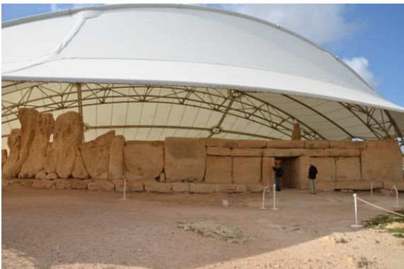
Fig. 83 : Ruine couverte par un toit membranaire
