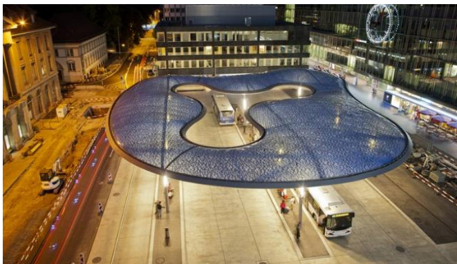
Fig. 85 : Arrêt de Bus à Aarau
