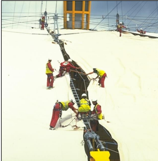
Fig. 55 : Installation de la membrane du dôme du millénaire
