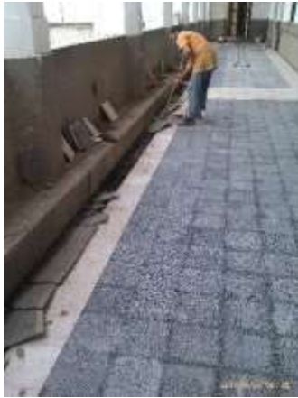
Fig. 4,129 : Reprise du revêtement du sol Source : B.E.T Harchaoui.2010
