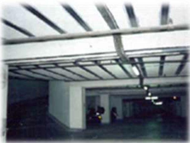
Fig. 3, 72 : renforcement d'un plancher d'un parking en RFC Source : Si Taieb, CNERIB 2010
