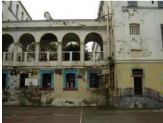
Fig. 4,121.122 : Dégradation du revêtement des murs suit à l'action de l'humidité
