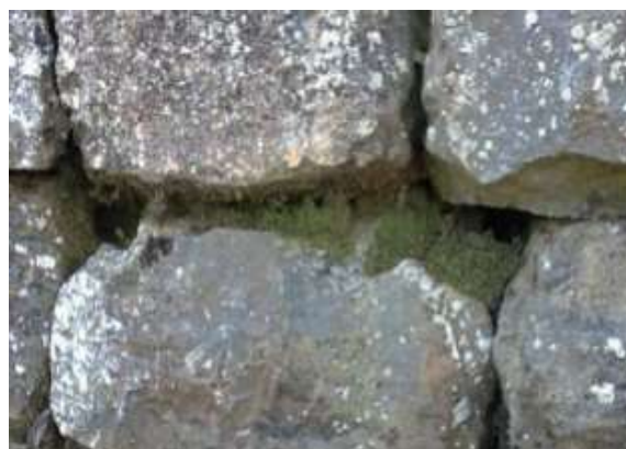
Fig 2.48 : Développement de la mousse dans les joints. Source : S.Allili, p 108
