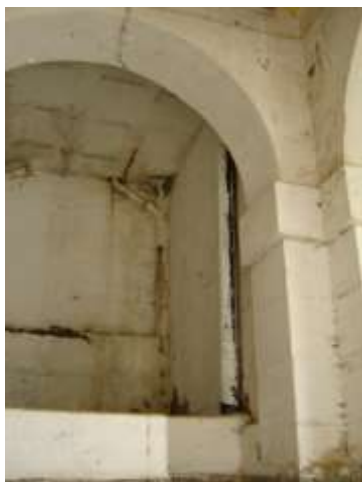
Fig 38 : plancher affecté par les Infiltrations.
