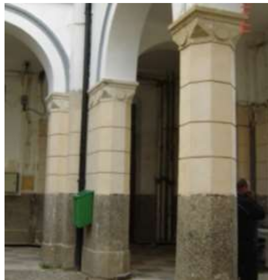
Fig. 4.111 : Colonnes de la galerie de forme hexagonale Source : B.E.T, Harchaoui,2010.
