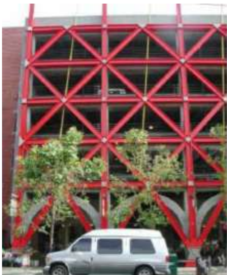
Fig. 3,67 : Contreventement amorti d'un bâtiment. Source : N.Attari, Cours 2015
