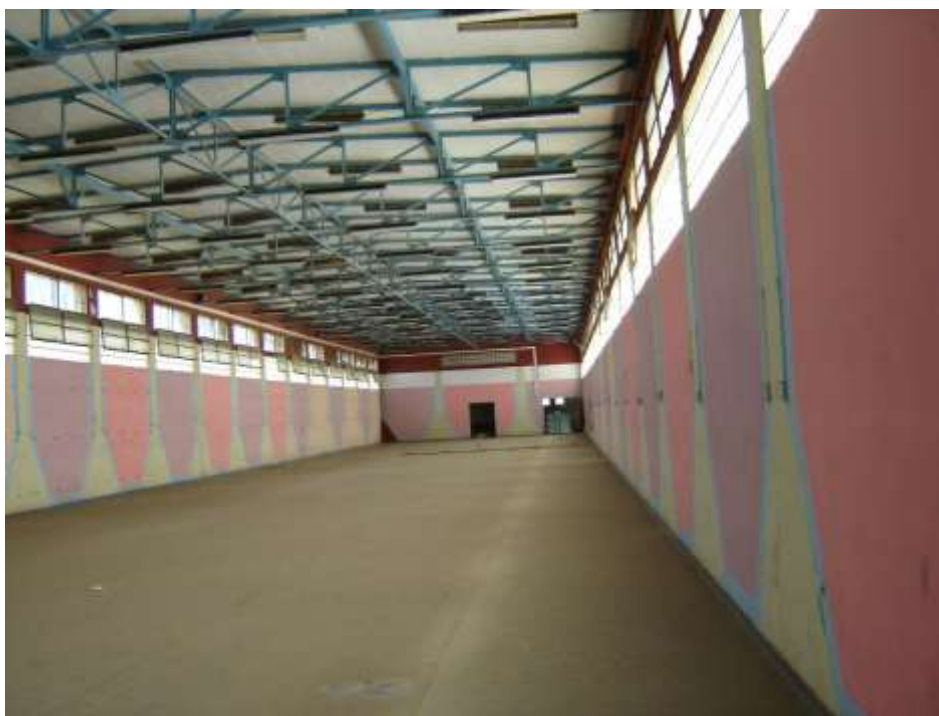
Fig. 4.118 : la salle de sport au 3 em étage du bloc 4 Source : B.E.T Harchaoui.2010
