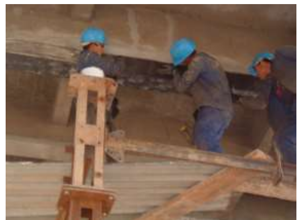
Fig. 3, 73 : renforcement d'une voûte en RFC Source : N.Attari, cours, 2015.
