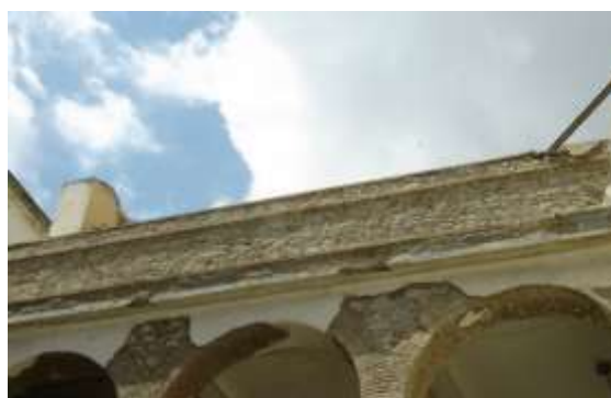
Fig. 4,112 : arcade en brique pleine sur colonne en pierre, Mur du garde-corps avec maçonnerie du Moellon. Source : B.E.T, Harchaoui, 2010.
