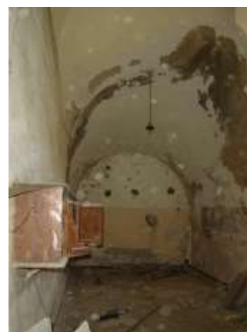
Fig. 4,113 : grande voute supportant le plancher de l'entresol Source : B.E.T, Harchaoui,2010.
