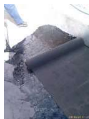
Fig. 4,128 : Reprise de l'étanchéité en multicouche
