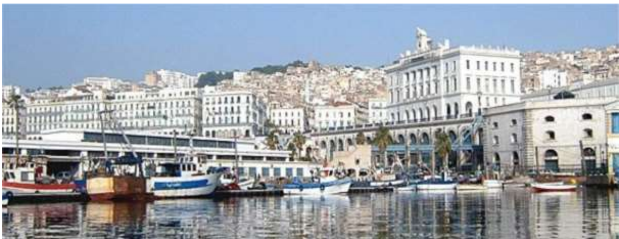
Fig. 4,88 : Vue panoramique de la Casbah d'Alger. Source : http://4.bp.blogspot.com/
