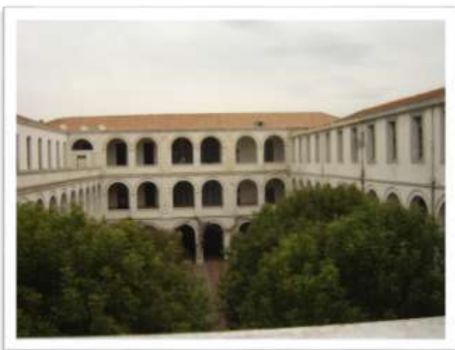
Fig. 4,100 : Façade Latéral du bloc administration. Source : B.E.T Harchaoui.2010.
