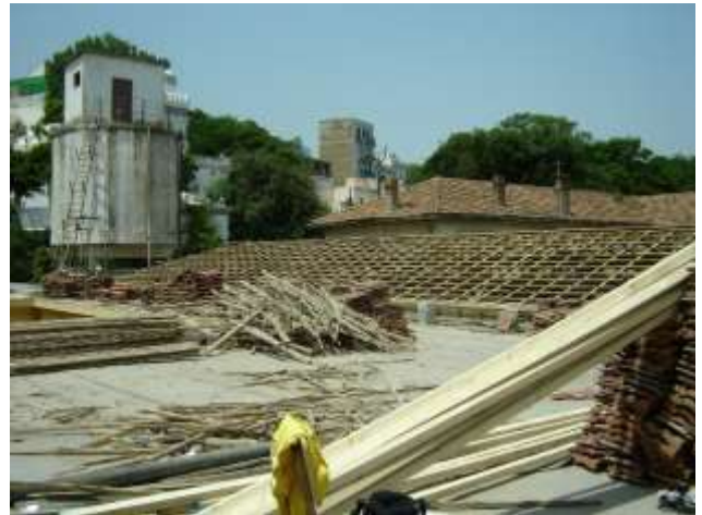
Fig. 4.171 : Le château d'eau sur terrasse Source : B.E.T Harchaoui.2010
