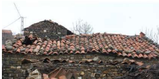
Fig 2.46 : Un soulèvement des tuiles suit à un vent fort Source : S.Allili p 98
