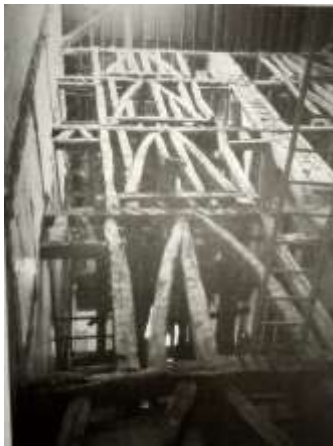
Fig 2.22: Refend longitudinal en pan de bois (milieu du 19 em siècle)
