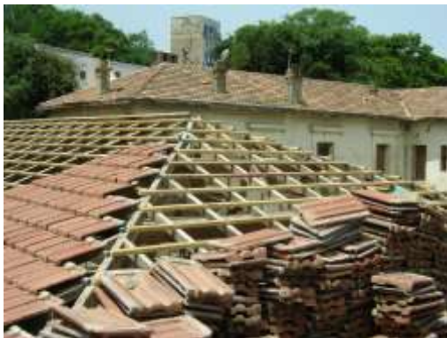
Fig. 4.134 : Nettoyage et repose des bonnes tuiles.
