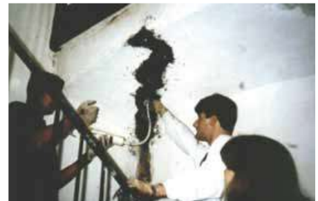
Fig 3, 61 : injection du coulis sous pression Source : X.Casanova, op cité p 214
