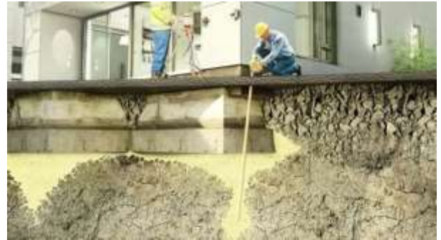
Fig 3.51 : Injection du sol sous pression sous la fondation
