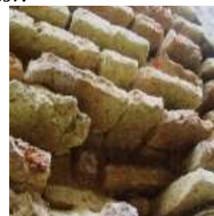
Fig 2.12 : Mur détérioré en maçonnerie de Brique
