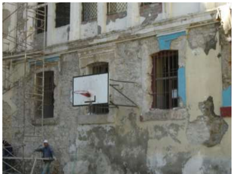
Fig. 4,110 : Mur extérieur en maçonnerie de moellon Au RDC, étage colonne de forme hexagonale en pierre de calcaire et remplissage avec la Brique rouge
