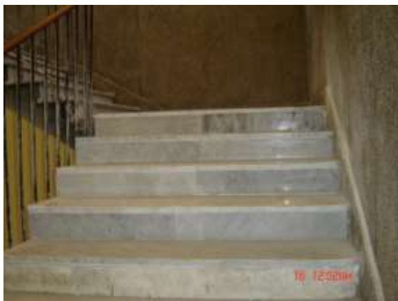
Fig. 4.136 : Pose de marche et de contre marche en marbre.
