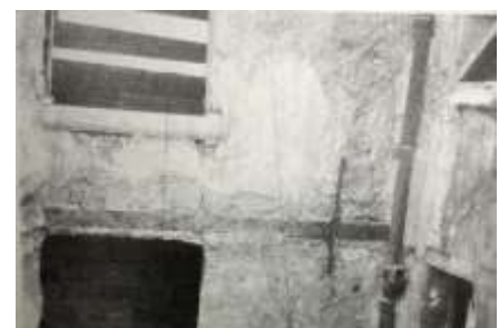
Fig 2.16: Un chainage horizontal en bois.
