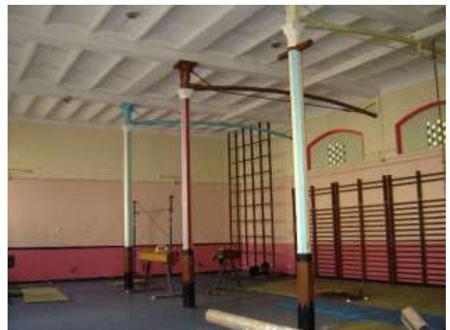
Fig. 4,117 : colonnes intermédiaires, salle de Gym
