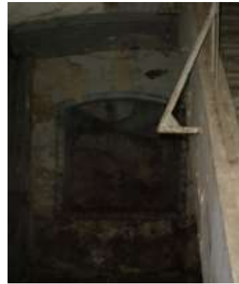
Fig. 4,121.122 : Dégradation du revêtement des murs suit à l'action de l'humidité
