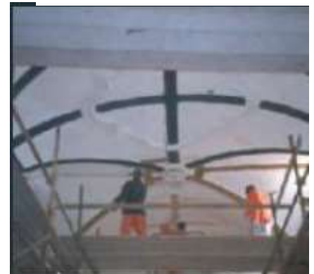
Fig. 3, 71 : renforcement de la structure du pont El Harrach en RFC Source : Si Taieb, CNERIB 2010
