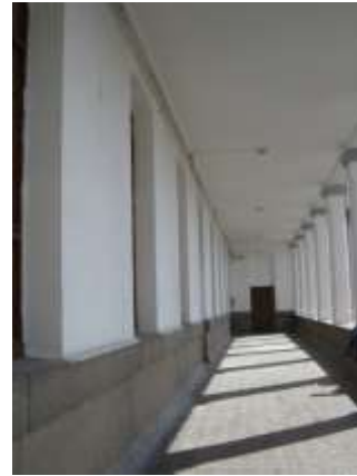
Fig. 4,130 : Etat du plancher de la galerie après finition des travaux Source : B.E.T Harchaoui.2010
