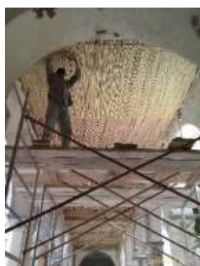
Fig. 4,127: La pose des faux plafonds en lattes roseaux.
