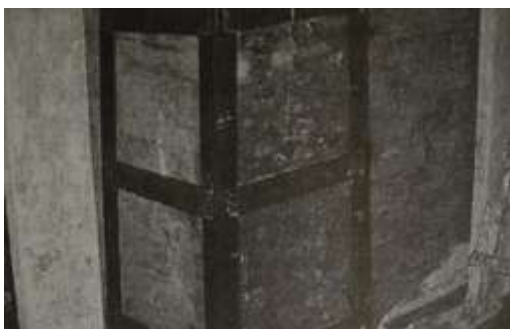
Fig 3. 64 : Gainage d'un tronçon d'un mur (vue d'angle) Source : M.Dekhmouche, op cité, p 26
