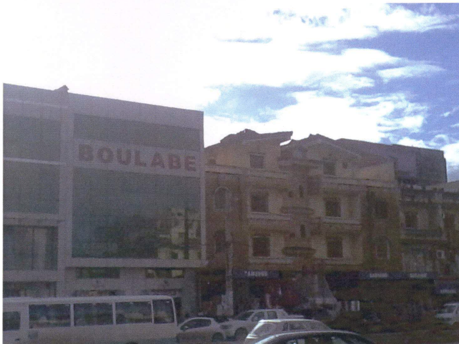
Figure N°17, Façade sur RN5 du quartier Freri 1.
