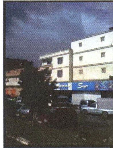
Figure N°25: Magasin « Safir » sur RN5, source photo prise l'auteur
