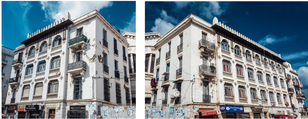
Figure 52 : Image montre les deux immeubles de fonctions.
