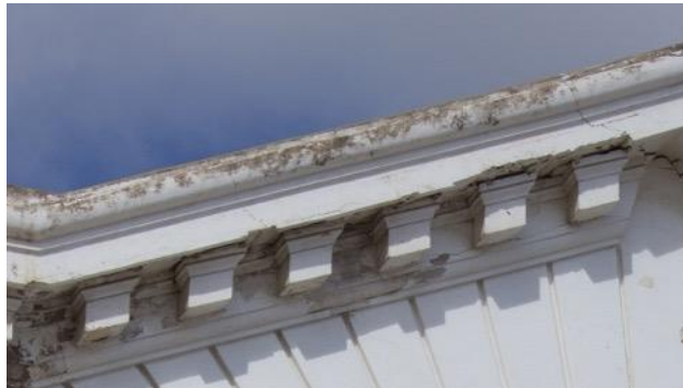
Figure 120 : détail de la corniche a Modillons
