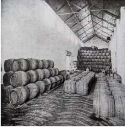
Figure 79 : Image montre les tonneaux du vin pour le descendre par le monte-charge.
