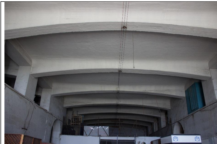
Figure 91 : Image qui montre les poutres cintrées.
