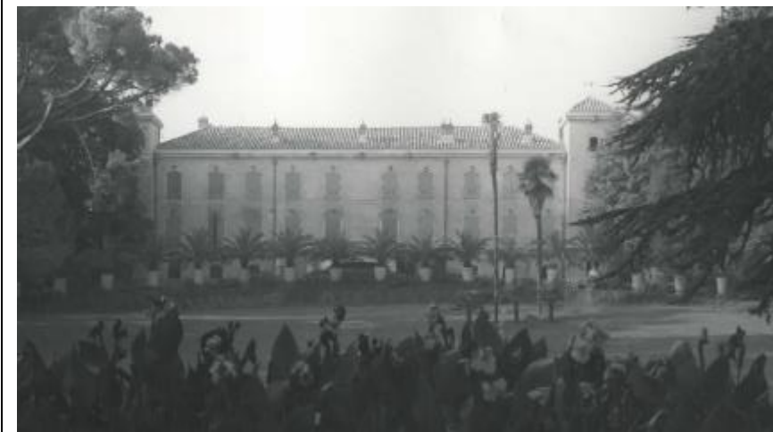
Figure 36 : Façade nord du cellier
