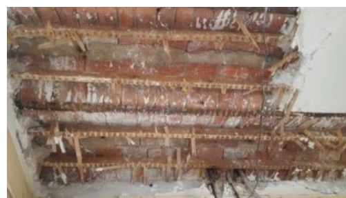
Figure 60 : Plancher en voutain avec faux plafond
