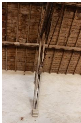
Figure 68 : image montre un élément architectural le corbeau qui joue une fonction esthétique et porteuse de charpente.
