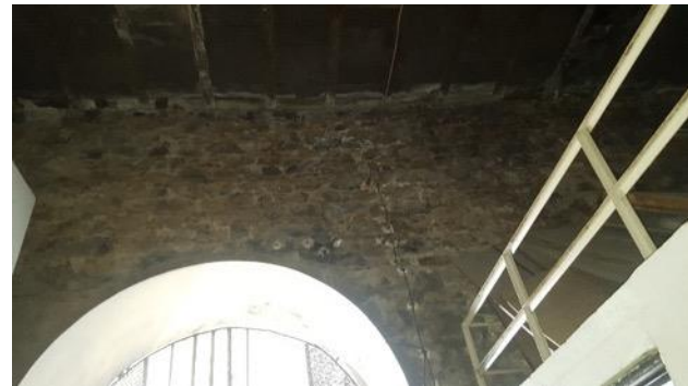
Figure 89 : mur du bâtiment.
