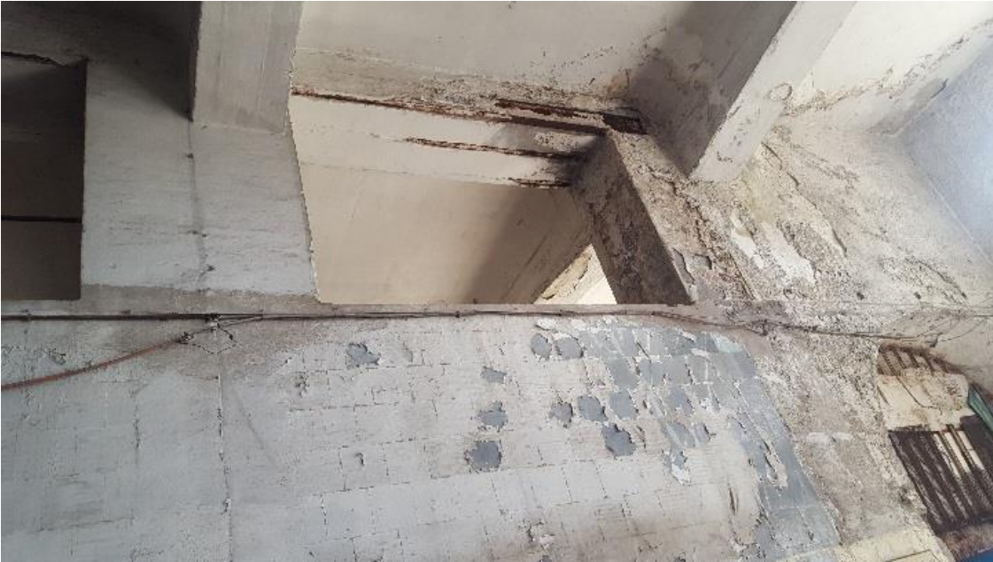
Figure 93 : image de murs intérieur recouvert en carreaux de verre blanc
