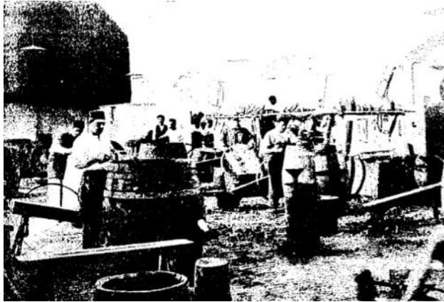
Figure 21 : Nettoyage des filtres
