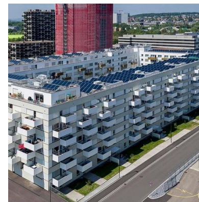
Figure 39 : Panneaux solaires photovoltaïques sur les bâtiments d'habitat collectifs
