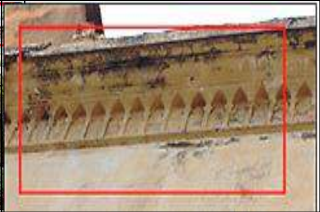
Fig 14 : corbeaux d'une façade extérieure ( Auteur, 2010)
