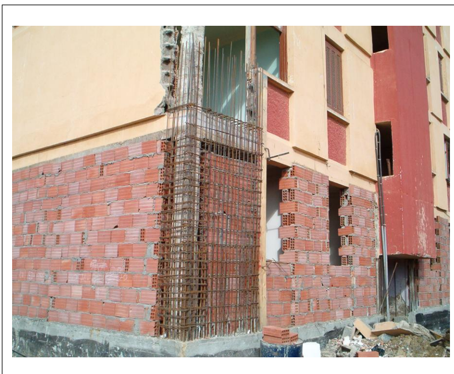
Photo.36. Ajout de mur de contreventement
