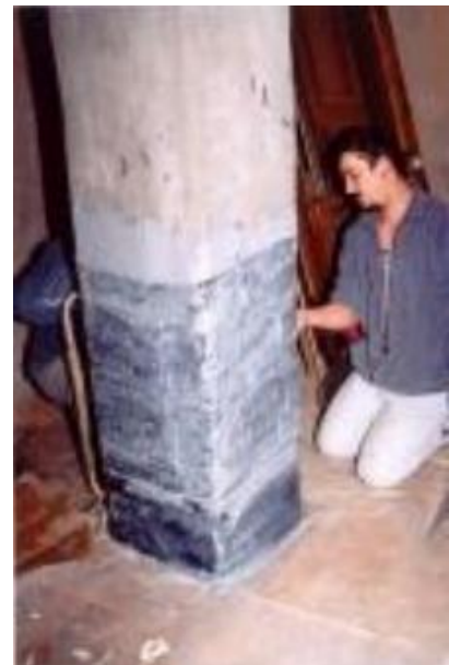
Photo.37. Renforcement de poteau par fibre de carbone
