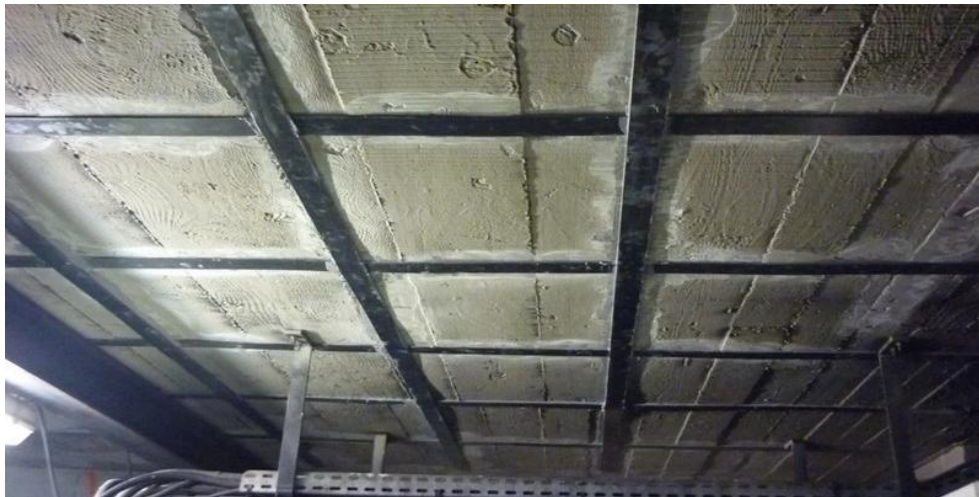
Photo.35. Renfort de plancher par bandes d'acier collé.
