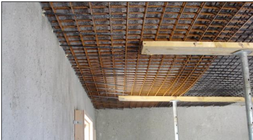
Photo.34. Renfort de dalle par enrobage inférieur/chemisage.
