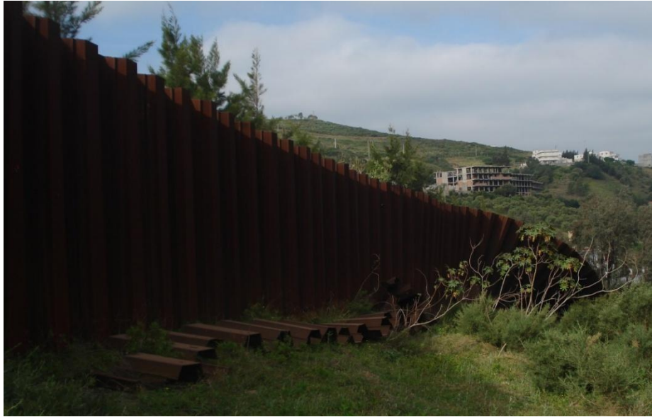
Photo.39. Rideau de palplanches.
