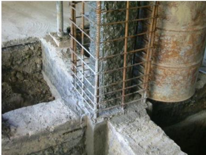
Photo.31. Chemisage d'un poteau en béton armé
