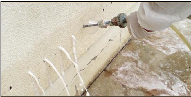
Photo.28. Injection de résines dans le bas d'un mur pour bloquer les remontées capillaires imperméabilité.
