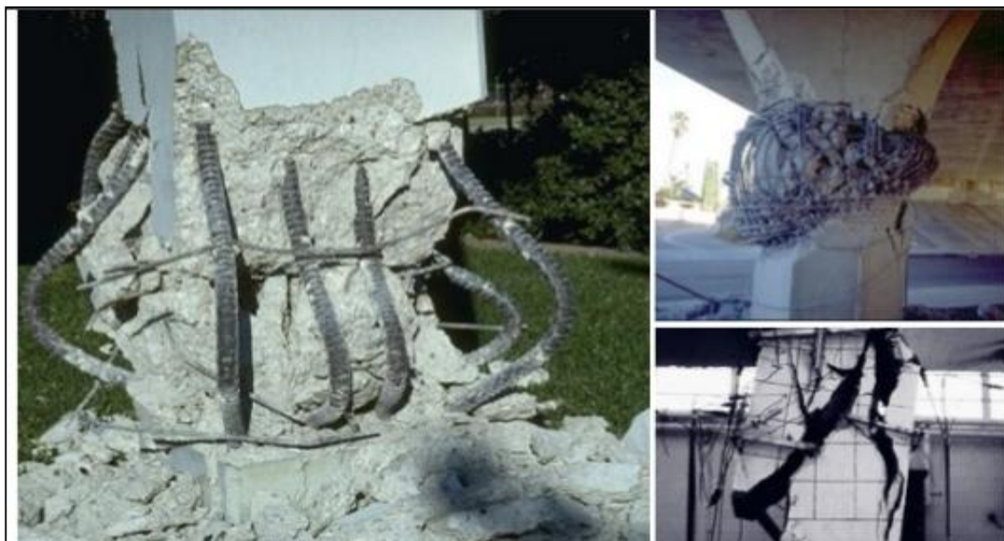
Photo.14. Poteau écrasé sous l'effet de charges dépassant la résistance de l'élément à la compression Source : www.slideshare.Net
