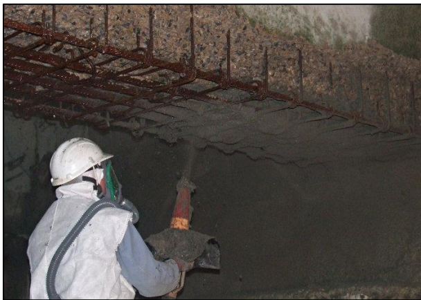
Photo.32. Projection de béton pour le chemisage d'une poutre en béton.
