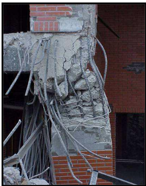
Photo.19. Chichi 1999/ Manque de confinement du nœud de liaison, poteau de rive et poutre. Source : Groupe de travail AFPCSTB, Diagnostic et renforcement du bâti existant vis-à-vis du séisme, CSTB, Mars 2013, p62
