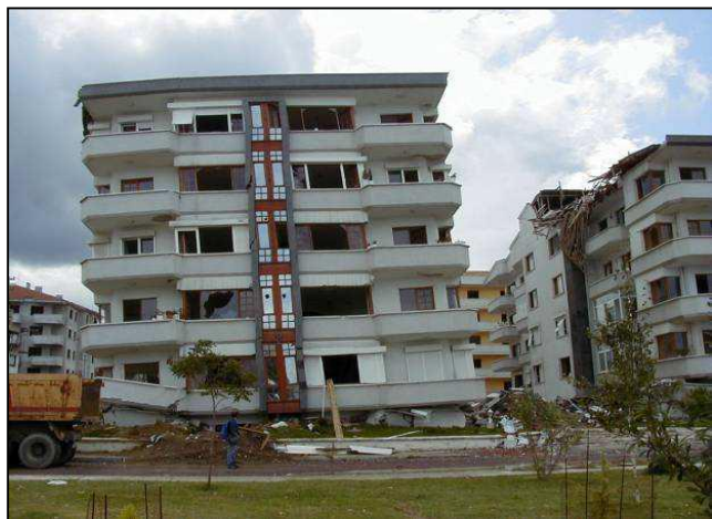
Photo.16. Effondrement du premier niveau suite du séisme de Kocaeli (Turquie) en 1999. Source : Groupe de travail AFPCSTB, Diagnostic et renforcement du bâti existant vis-à-vis du séisme, CSTB, Mars 2013, p61
