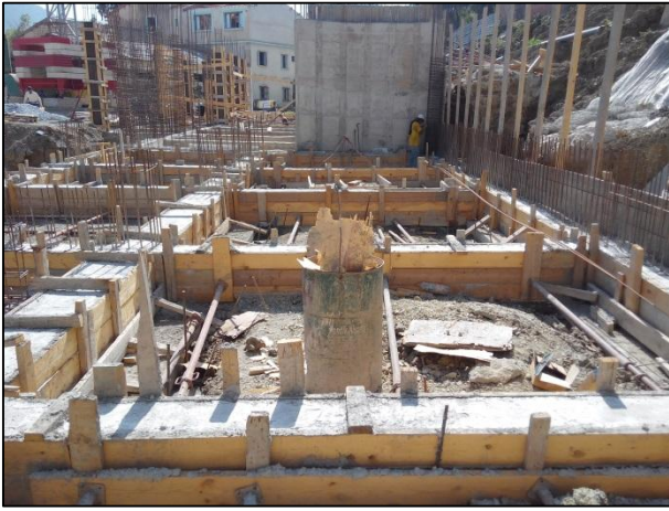
Photo.1. Photo d'une infrastructure en béton armé
