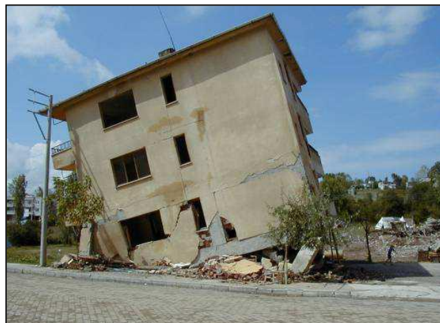
Photo.16. Effondrement du premier niveau suite du séisme de Kocaeli (Turquie) en 1999. Source : Groupe de travail AFPCSTB, Diagnostic et renforcement du bâti existant vis-à-vis du séisme, CSTB, Mars 2013, p61
