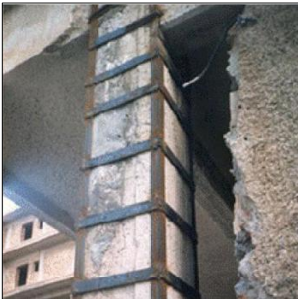
Photo.29. Chemisage en acier d'un poteau.
