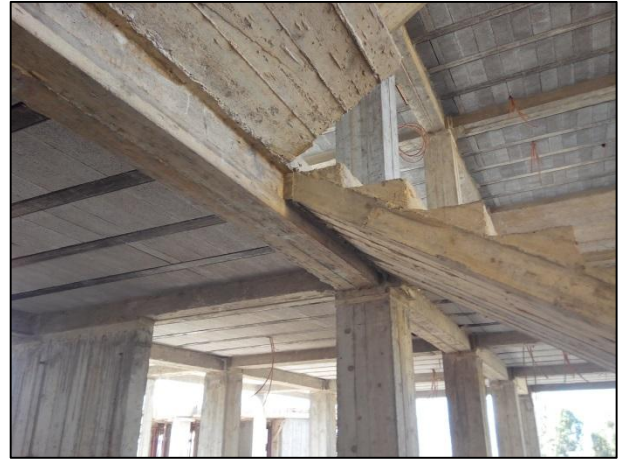
Photo.2. Photo d'une structure en béton armé
