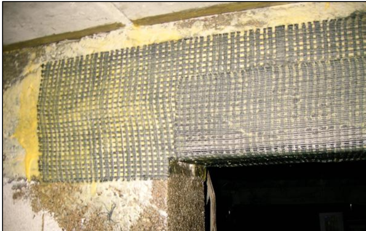
Photo.38. Renforcement de poutre par fibre de carbone
