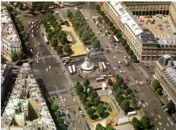
Figure 29: Vue aérienne de l'ancienne place.
