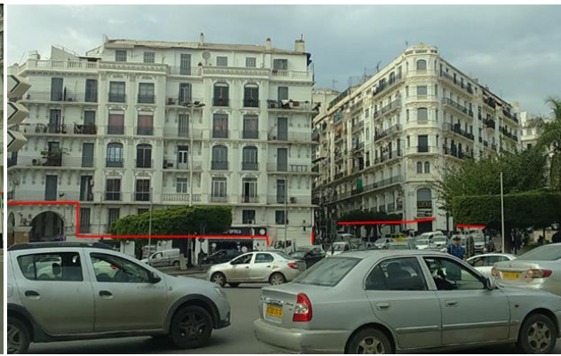
Figure 58: La paroi Est de la place dont le RDC est destiné aux commerces.
