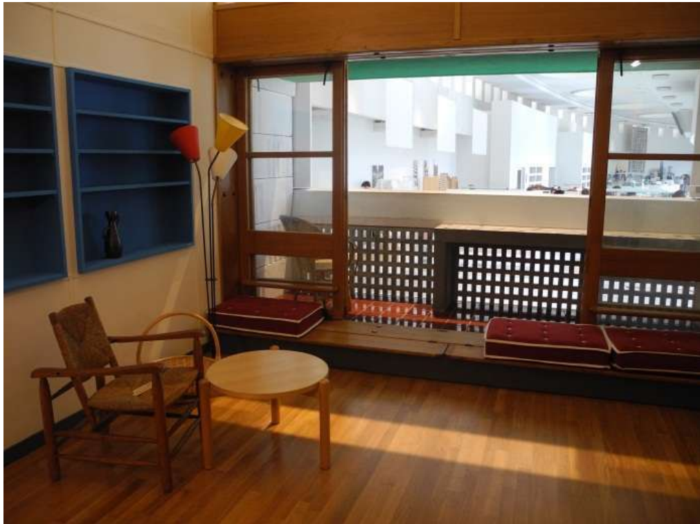
Fig. 11 Vue sur le banc de bois dissimulant le système de chauffage électrique à l'Unité d'habitation de Marseille.
