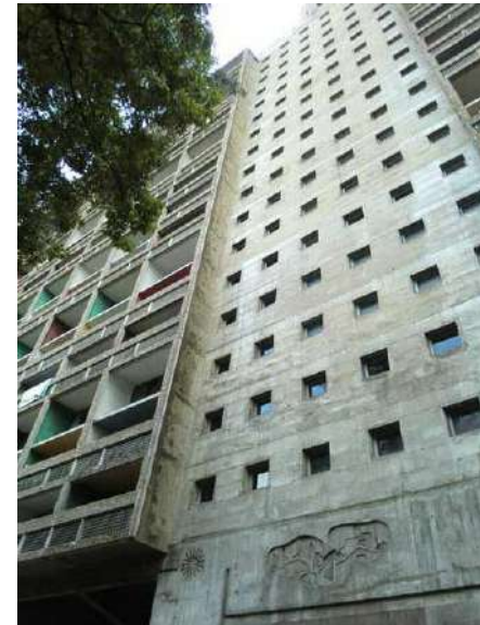
Vue sur les éléments en béton brut coulé de l'Unité d'habitation de Marseille. En haut: Les pilotis. En bas : La façade des circulations verticales.
