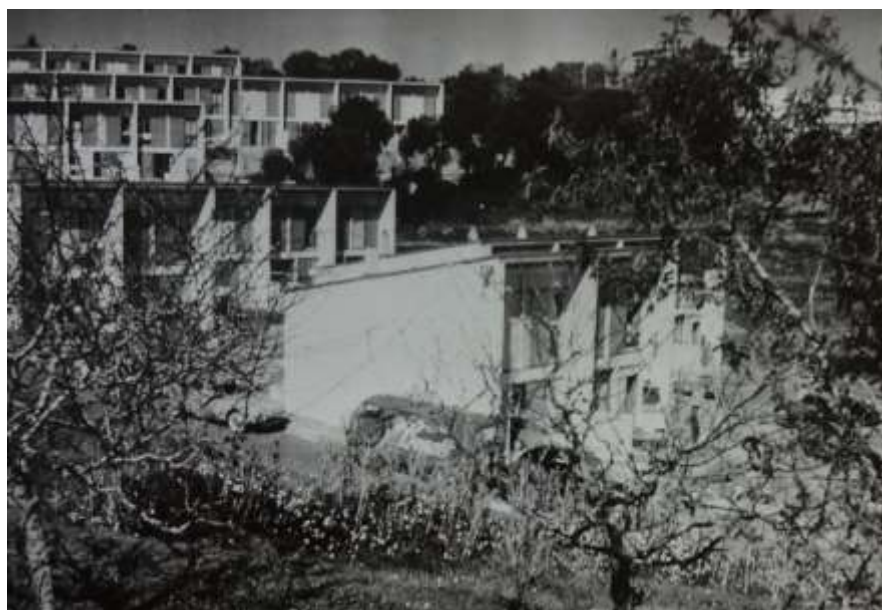
Fig. 13 Vue sur le bâtiment 1 et les maisons individuelles disposées au sud du terrain, n.d.
