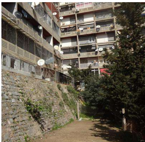
Vue sur le mur de soutènement séparant le bâtiment 3 de l'Aéro-habitat de l'extérieur, février 2014. Source : Photos prise par l'auteur.
