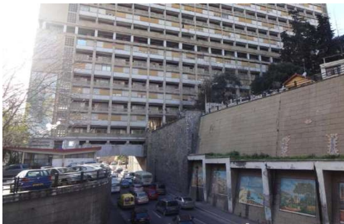
Vue sur le passage du Boulevard du Télémly (actuel boulevard Krim Belkacem ) sous l'immeuble 2 de l'Aéro-habitat, avril 2014.
