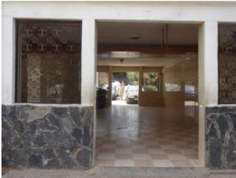
Fig. 3 Vue sur le hall de l'entrée principale du bâtiment 2 de la cité Henri Sellier, ce hall permet l'accès à la galerie de desserte du r.d.c et il n'est délimité par aucune porte, juin 2013.
