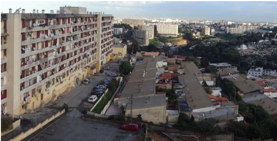
Vue sur la configuration urbaine de la cité Henri Sellier prise à partir de la galerie du bâtiment 2 (Tissu serrée de maisons individuelles disposées au pied d'un immeuble barre), juin 2013.
