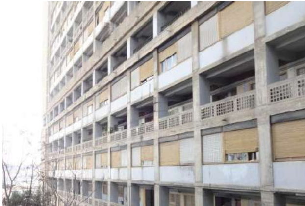
Vue sur une des coursives de déserte de l'Aéro-habitat en façade, avril 2014.
