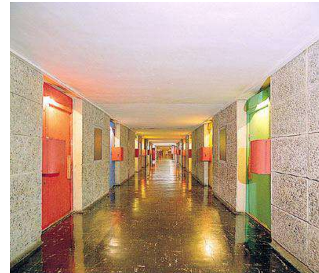
Vue sur une des « rues interieures2 de l'Unité d'habitation de Marseille.
