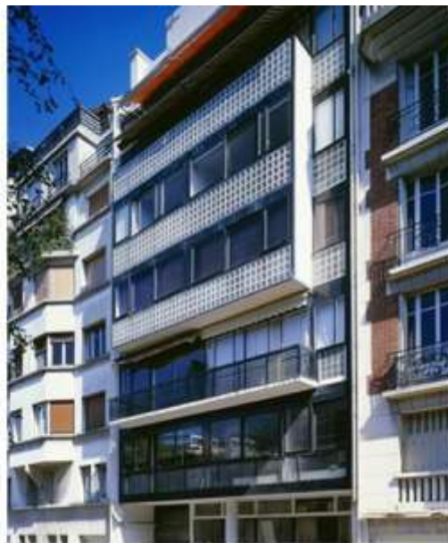
Fig. 4 Le Corbusier, L'immeuble Molitor, Paris, 1931-1934. Source : Le Corbusier (1935), Œuvre... , p.74.
