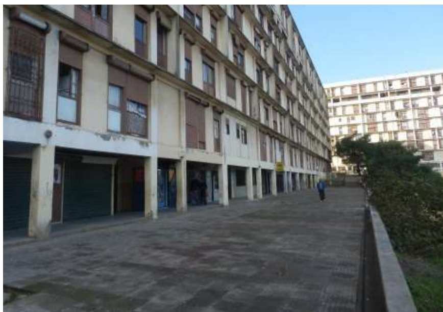
Fig. 22 Vue sur la plate-forme piétonne bordant l'immeuble 1 de la cité Henri Sellier, juin 2013. Source : Photos prise par l'auteur.
