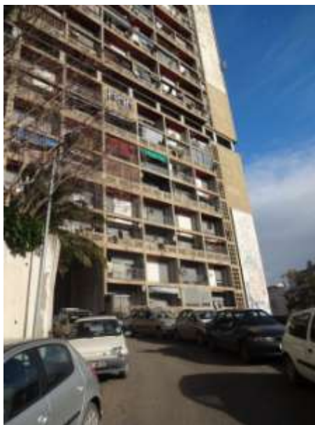
Fig. 17 Vue sur le passage de la rue Professeur Vincent (actuel rue Mirad Salah) sous l'immeuble 2 de l'Aéro-habitat, avril 2014.
