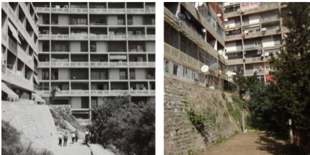
A Gauche Fig. 11 Vue sur le mur de soutènement séparant le bâtiment 3 de l'Aéro-habitat de l'extérieur, n.d. Source : Dossier 007 I.F.A. 61/3.
