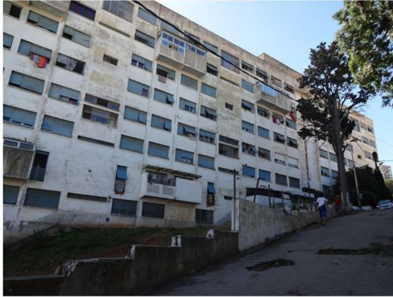
Fig. 26 Louis Miquel, Immeuble H.L.M rue Zaatcha, Alger, 1959-1960. Source : Photos prise par l'auteure, le 20.10.2012.
