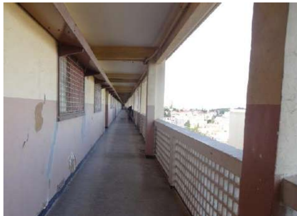
Vue sur la coursive de déserte du 6 ème étage de l'immeuble 2 de la cité Henri Sellier, avril 2014.
