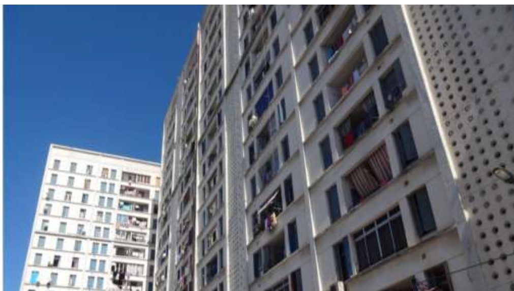
Fig. 19 Vue sur les immeubles E2 (à droite) et E3 (à gauche) du groupe Champ de Manœuvres, Alger.
