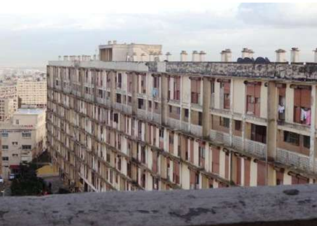
Vue sur la coursive de déserte du 7 ème étage de l'immeuble 1 de la cité Henri Sellier prise à partir de la galerie du 6 ème étage de l'immeuble 2, avril 2014.
